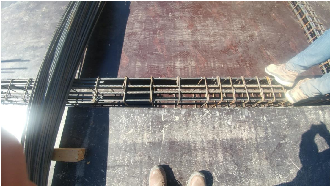
Figura 4.3.15: Armado de las vigas sobre el encofrado.
