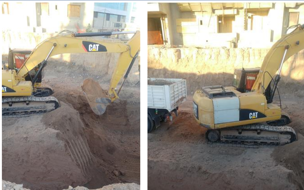
Figuras 4.4.2 y 4.4.3: Imágenes de excavación del Sector C
