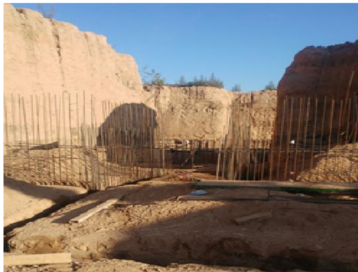
Figura 4.2.13: Imagen de Arranques de columnas.
