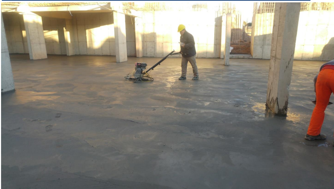
Figura 4.3.10: Alisado con llana Helicóptero.
