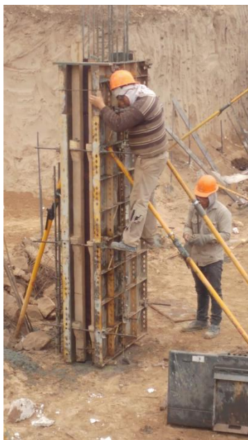
Figuras 4.3.3 y 4.3.4: Imagen de Encofrados de Columnas y tabiques.
