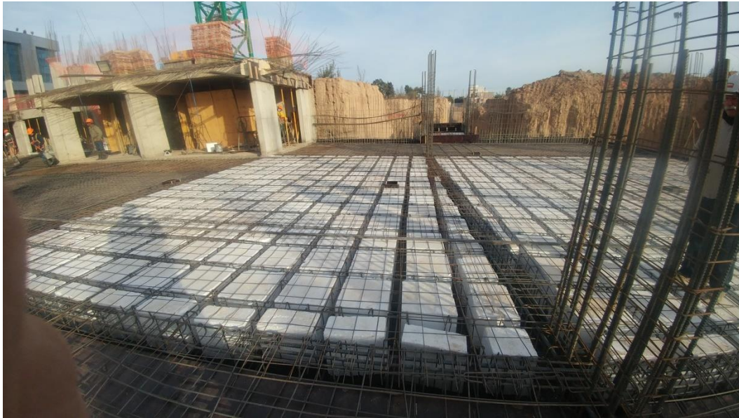
Figura 4.317: Imagen de la losa sobre segundo subsuelo previa al hormigonado.
