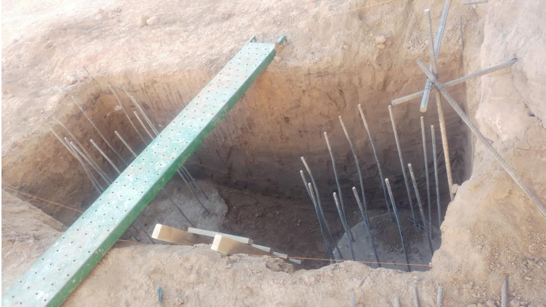
Figura 4.2.4: Excavación para la construcción del cabezal.
