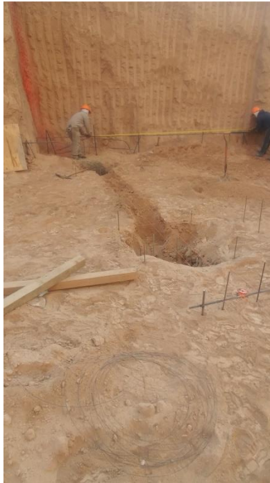
Figura 4.4.13: Imagen de excavación de Fundaciones – Sector C
