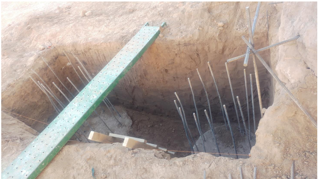
Figura 4.2.7: Imagen Cabezal de dos pilotes.
