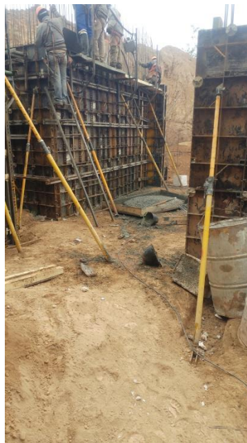
Figuras 4.3.3 y 4.3.4: Imagen de Encofrados de Columnas y tabiques.
