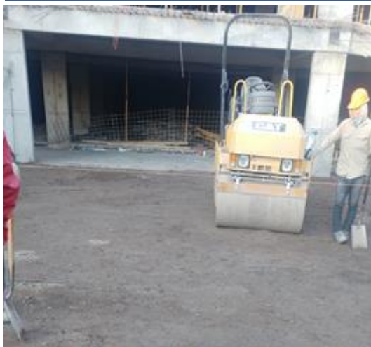
Figuras 4.3.7 y 4.3.8: Nivelación y compactación de suelo para contrapiso
