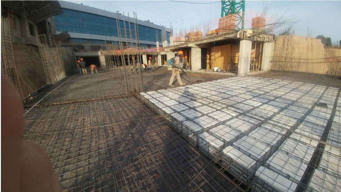
Figura 4.3.21: Imagen de limpieza de Encofrado previo al Hormigonado.
