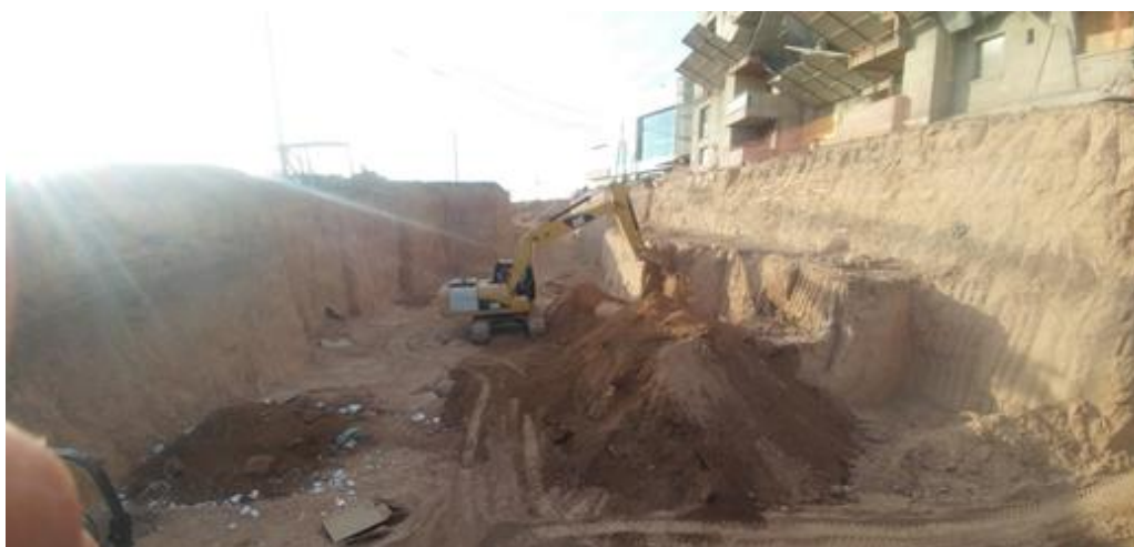
Figura 4.4.6: Excavación Sector C – Segunda etapa
