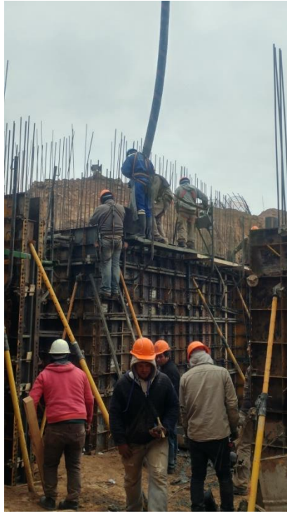
Figura 4.3.5: Hormigonado de los tabiques.
