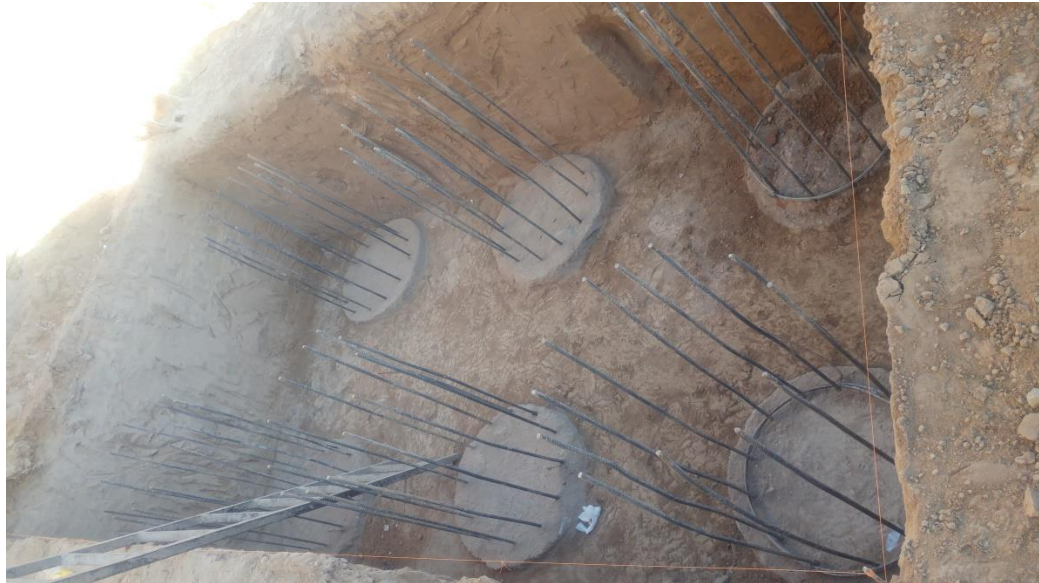
Figura 4.2.6: Imagen Cabezal de 6 pilotes
