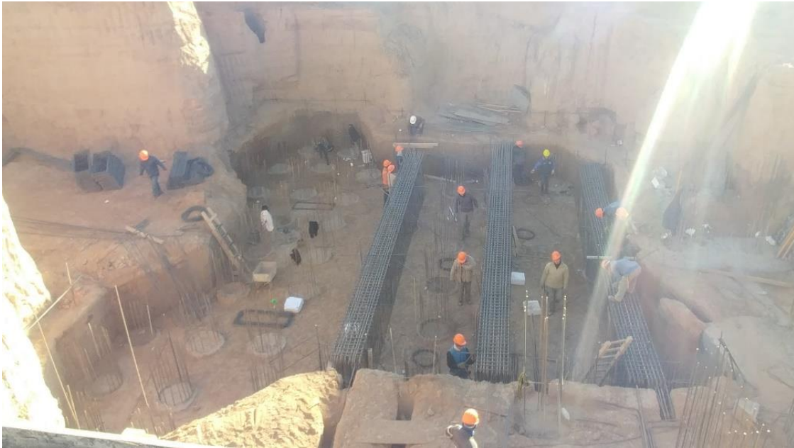
Figura 4.2.8: Imagen Cabezal de 65 pilotes.
