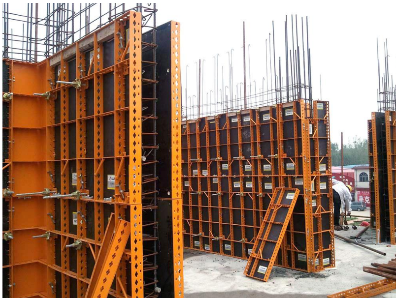
Figura 2.10: Encofrado de tabiques.
