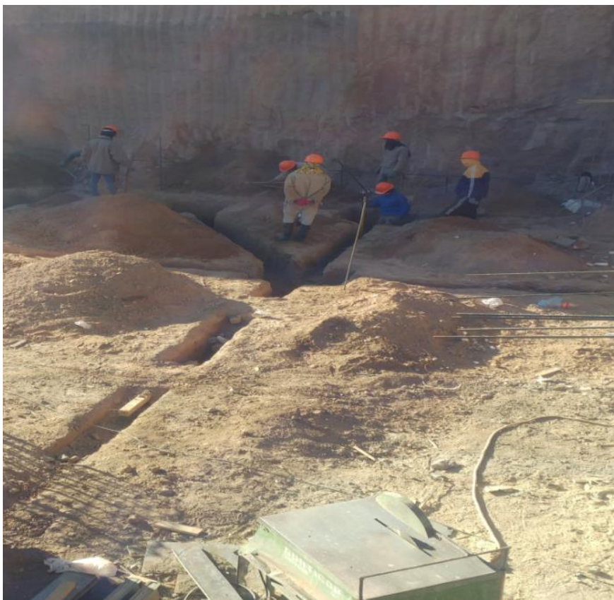
Figura 4.2.3: Excavación de fundaciones - vigas riostra.
