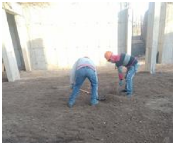
Figuras 4.3.7 y 4.3.8: Nivelación y compactación de suelo para contrapiso
