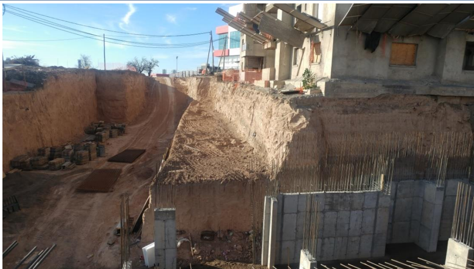
Figura 4.4.5: Excavación del Sector C – Primera etapa
