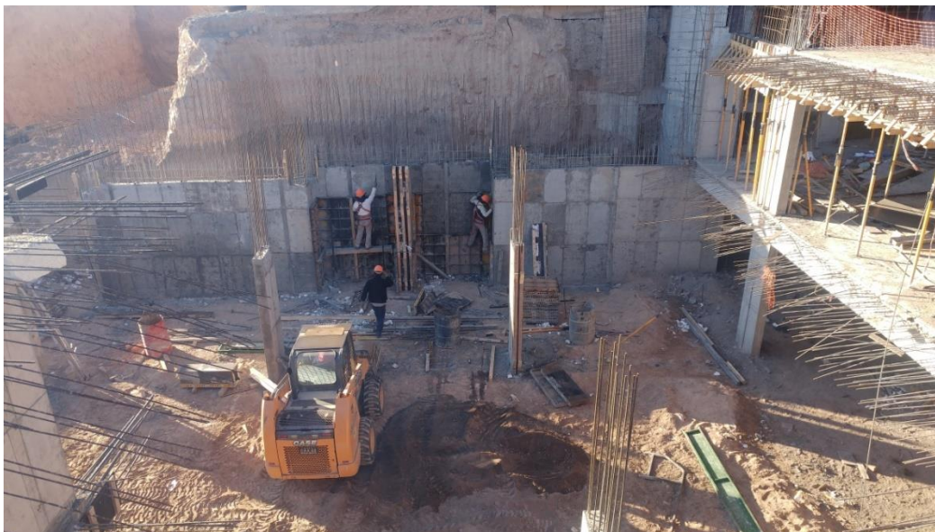
Figura 4.3.6: desencofrado de tabiques y columnas
