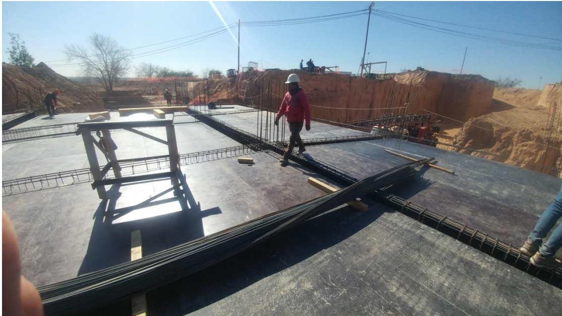
Figura 4.3.13: Encofrado de losa
