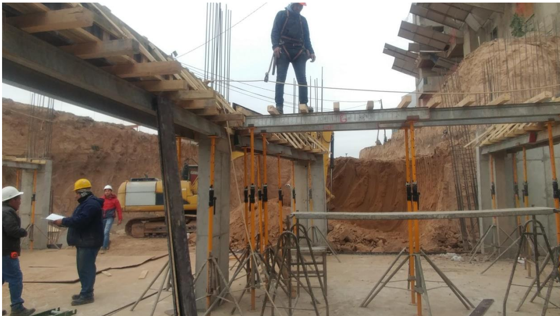
Figura 4.3.12: Encofrado de vigas.
