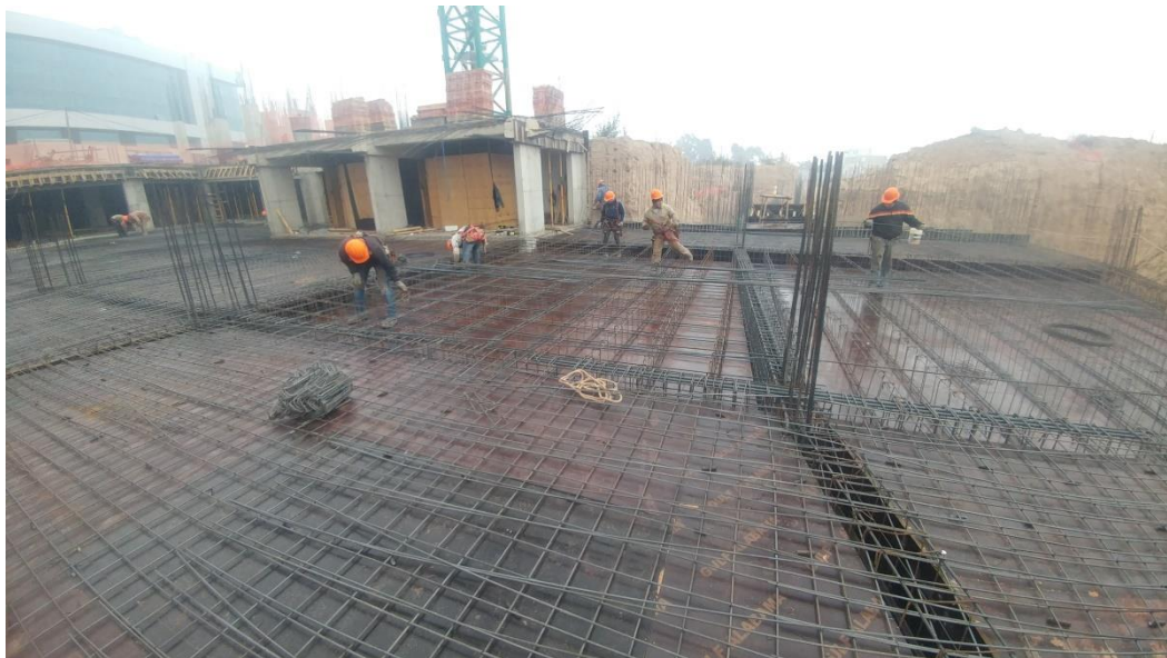
Figura 4.3.16: Colocación del metal desplegado sobre Losa de segundo subsuelo.
