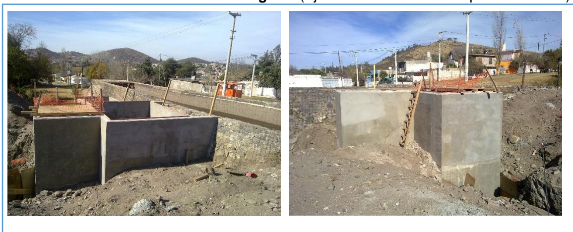
Fig. 9 – (Ejecución Obra de Toma para La Calera)
