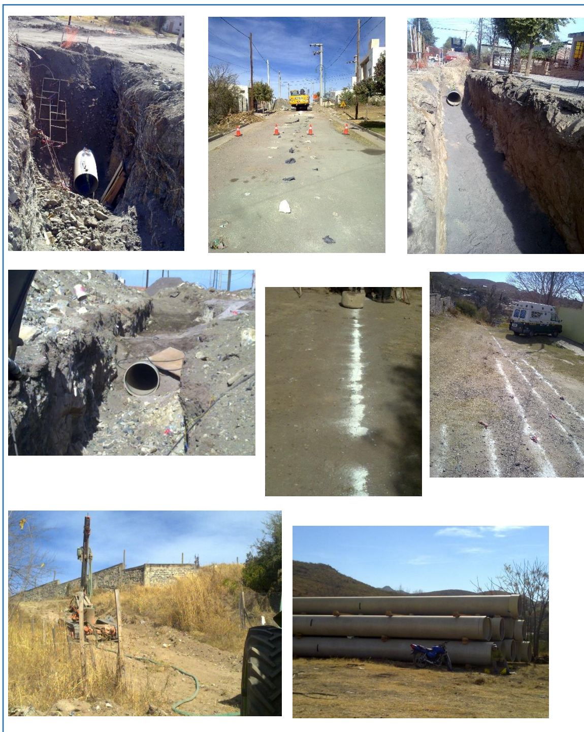
Fig. 10 – (Ejecución obra de aducción actual PRFV 800 mm)
