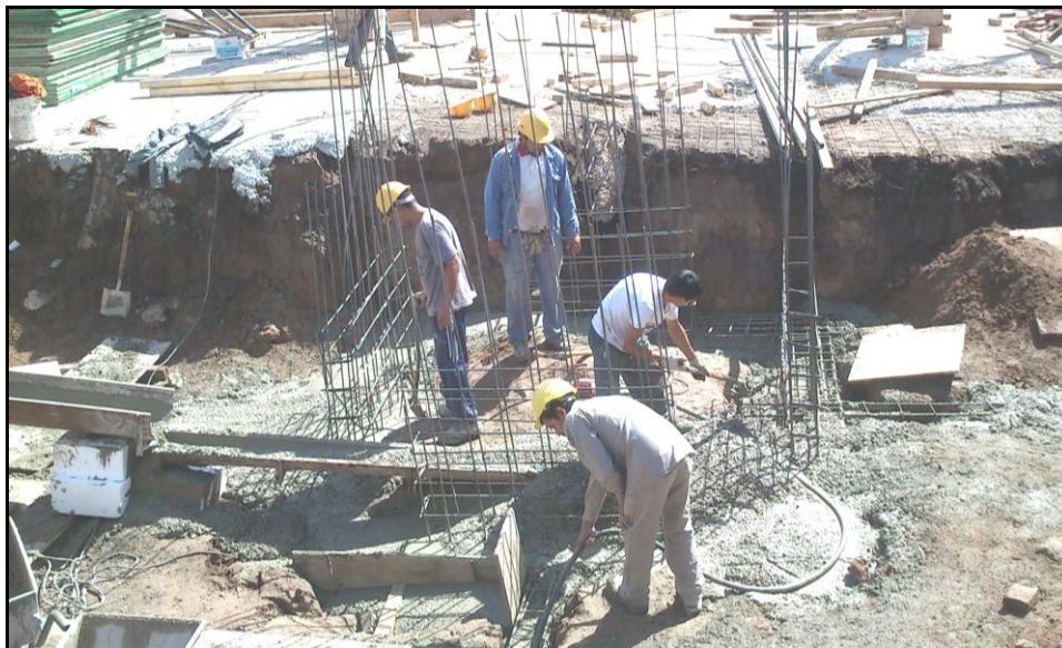
Figura 4.2.34: Fotografía tomada durante el hormigonado del núcleo de la rampa helicoidal.
