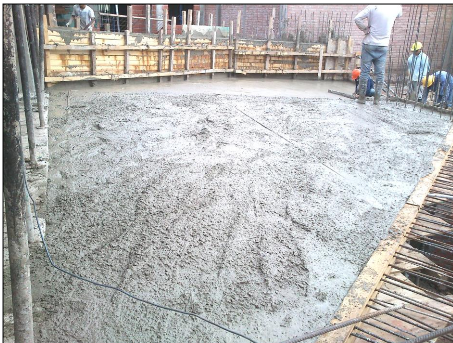
Figura 4.4.14: Fotografía durante la nivelación de la losa inclinada.
