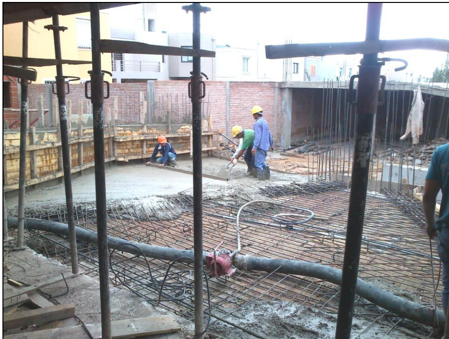
Figura 4.4.13: Fotografía durante el hormigonado de la losa inclinada.
