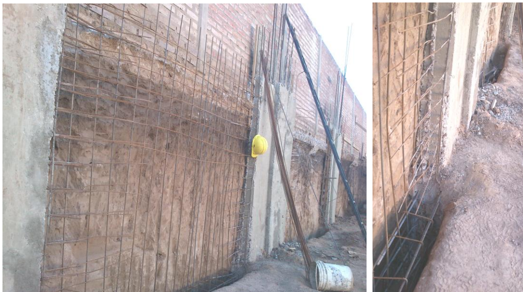
Figura 4.2.26: Fotografía de la armadura de los tabiques de submuración.
