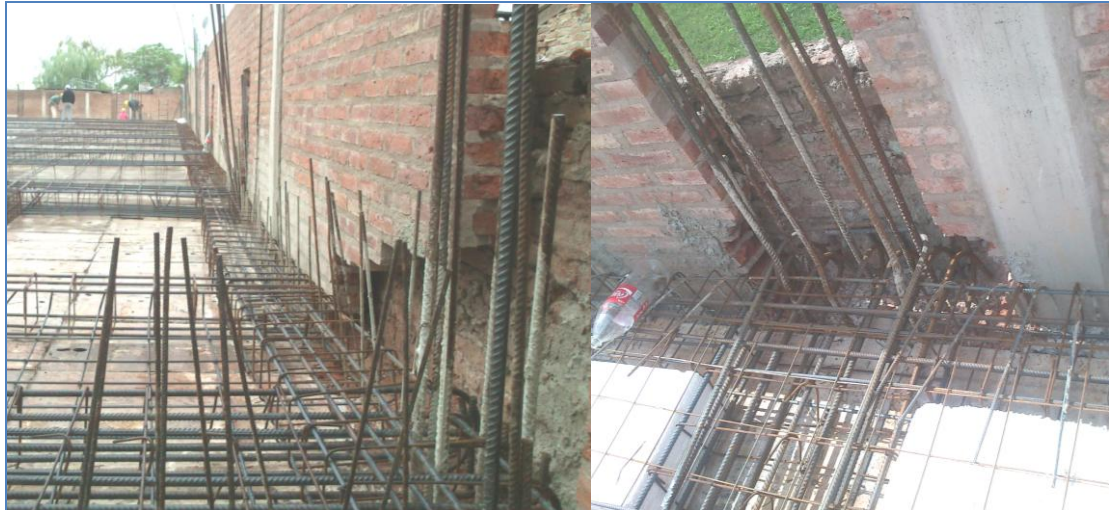
Figura 4.3.14: Ubicación de las vigas medianeras.
