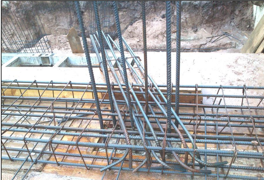
Figura 4.4.7: Armadura en espera para las vigas de apoyo de la rampa de circulación.
