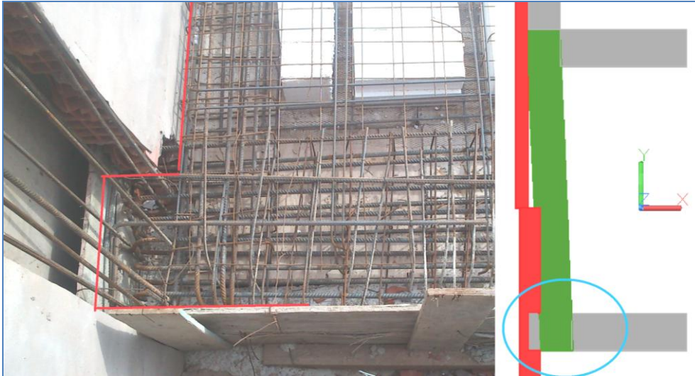
Figura 4.3.16: Imagen tomada de viga V1Y y su apoyo en C1 con la solución adoptada.
