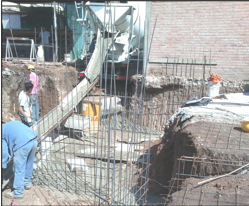
Figura 4.2.33: Disposición de los elementos para ejecutar el hormigonado.
