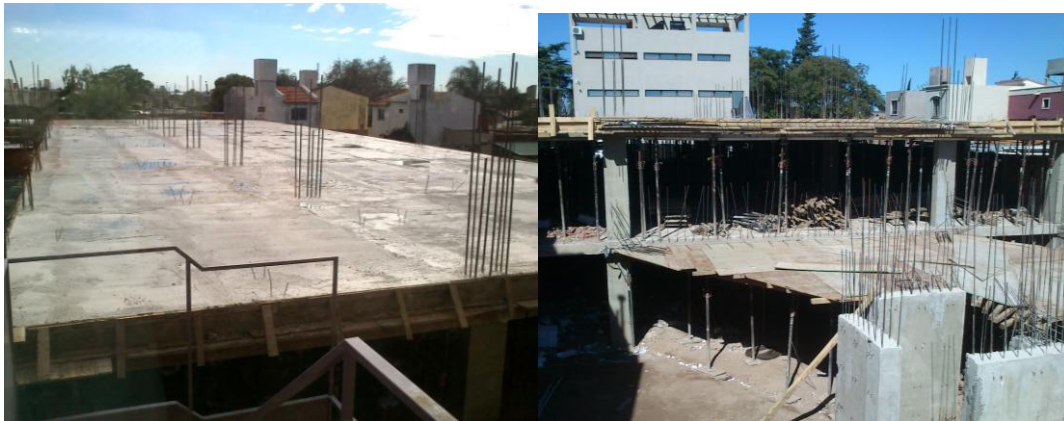
Figura 4.3.25: Vistas de las losas ya hormigonadas.
