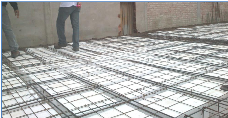
Figura 4.3.21: Imagen del armado de la losa nervurada.
