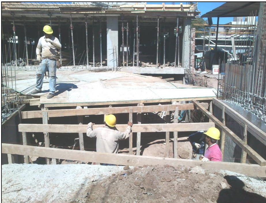
Figura 4.4.4: Imagen tomada durante el armado del encofrado de la rampa de circulación.
