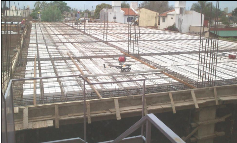
Figura 4.3.18: Imagen de la losa sobre planta baja previa al hormigonado.
