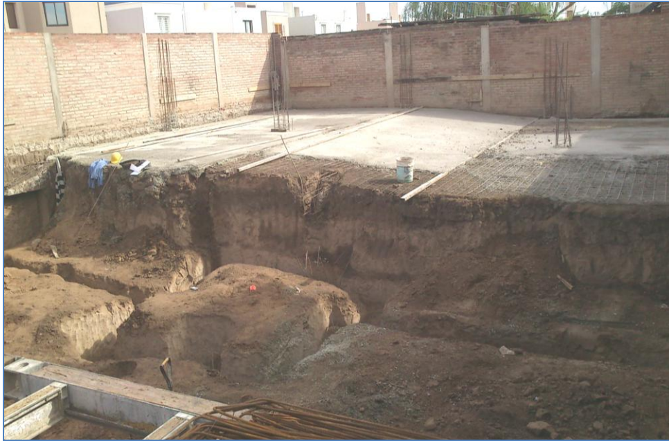
Figura 4.2.29: Fotografía tomada durante la construcción del contrapiso.
