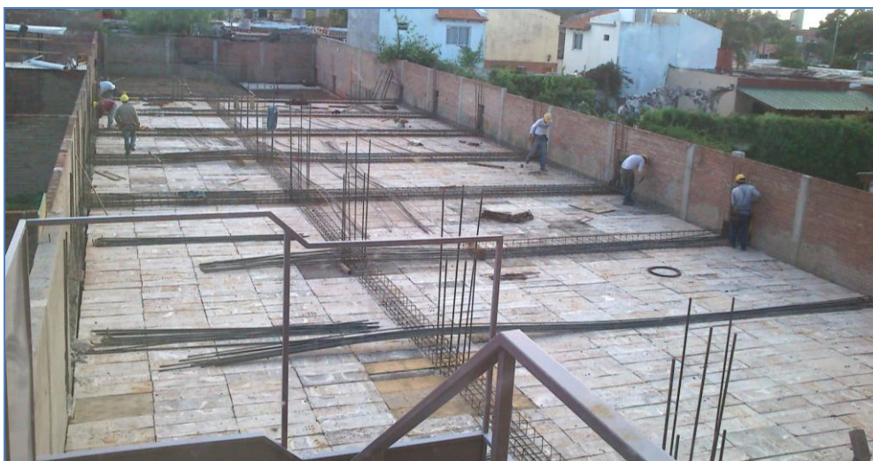
Figura 4.3.11: Armado de las vigas sobre el encofrado.
