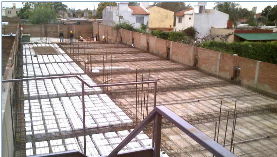
Figura 4.3.17: Imagen de la losa sobre subsuelo con la colocación de los molones.
