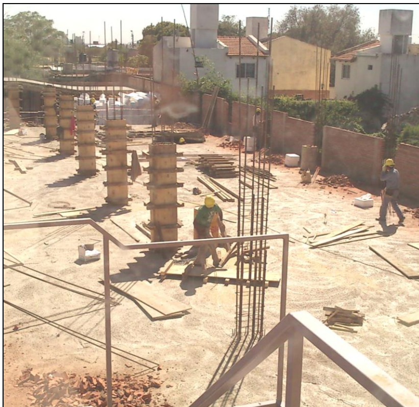
Figura 4.3.5: Montaje de los encofrados de columnas sobre Planta Baja.
