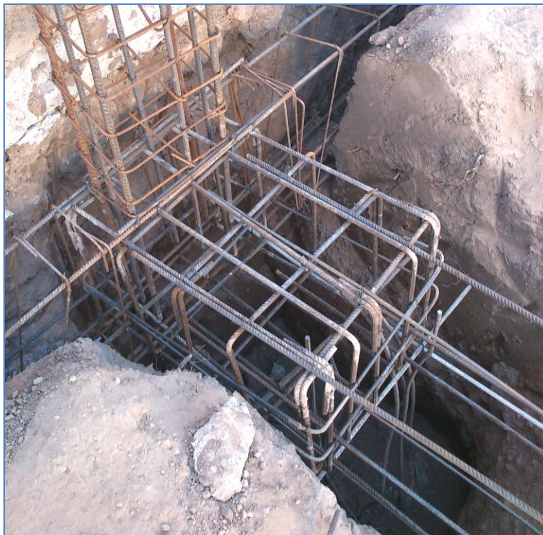
Figura 4.2.16: Armadura del cabezal con el arranque de columna.
