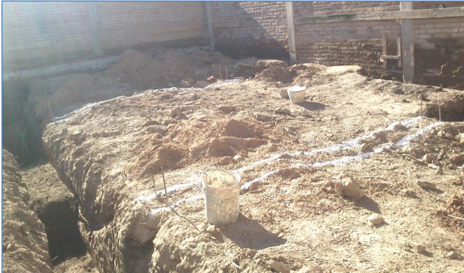
Figura 4.2.7: Replanteo de las vigas riostras
