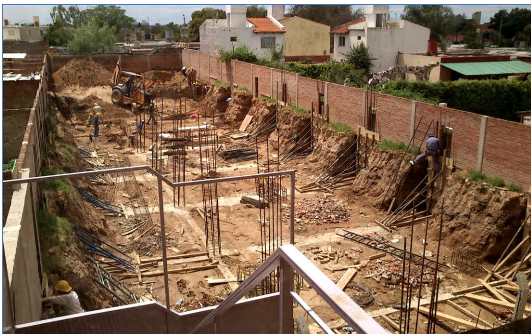
Figura 4.2.21: Fotografía tomada durante el encofrado de los tabiques perimetrales.
