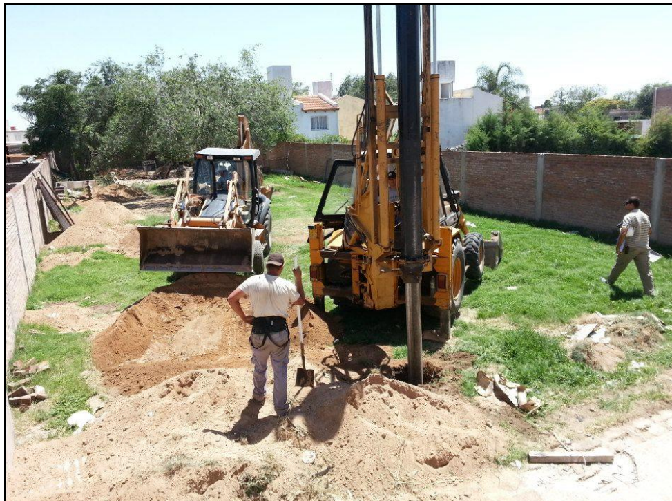
Figura 4.2.2: Perforadora rotatoria con punta de avance helicoidal.
