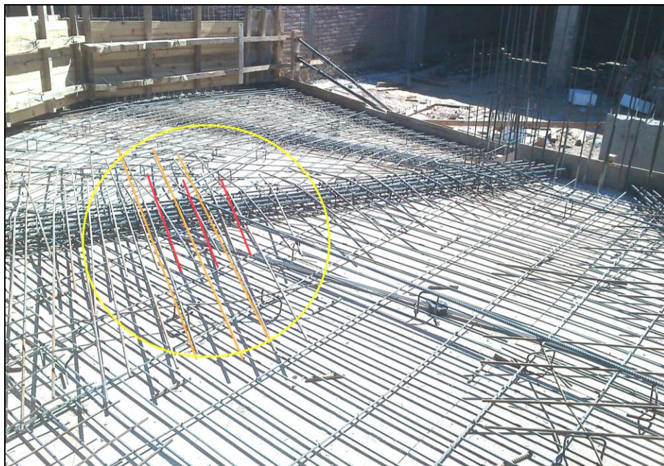
Figura 4.4.12: posicionamiento de la armadura superior de refuerzo con los complementos adicionales de mayor longitud.
