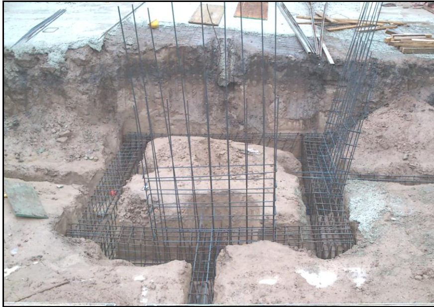
Figura 4.2.32: Fotografía tomada durante la ejecución de vigas riostras y cabezal.
