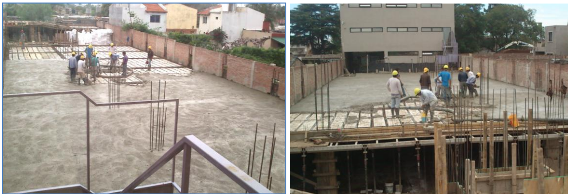
Figura 4.3.24: Imágenes tomadas durante el hormigonado de las losas.
