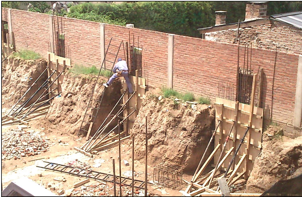
Figura 4.2.20: Fotografía tomada durante el encofrado de los tabiques perimetrales.
