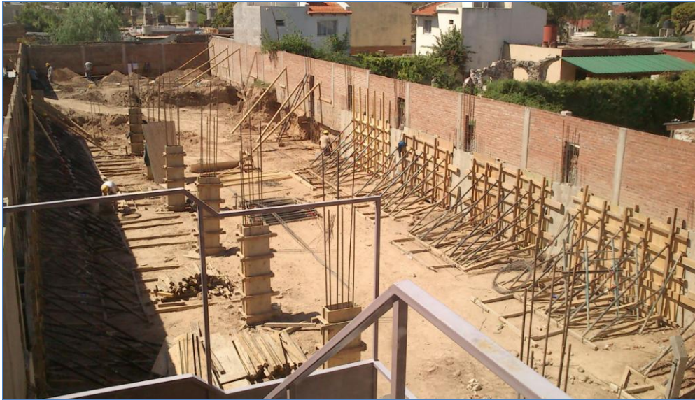
Figura 4.2.27: Fotografía de los encofrados de tabiques y columnas.
