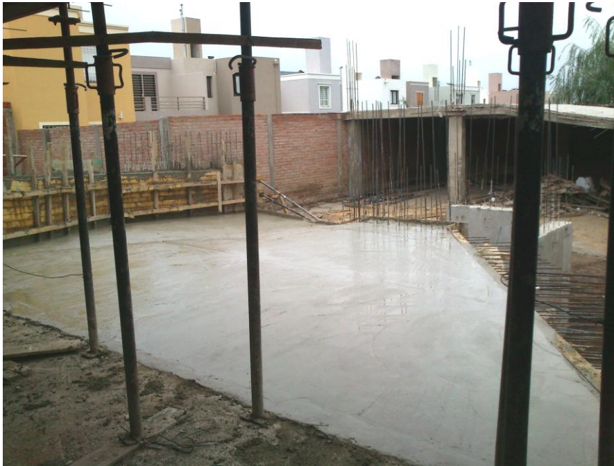
Figura 4.4.15: Fotografía que muestra la losa inclinada de la rampa terminada.
