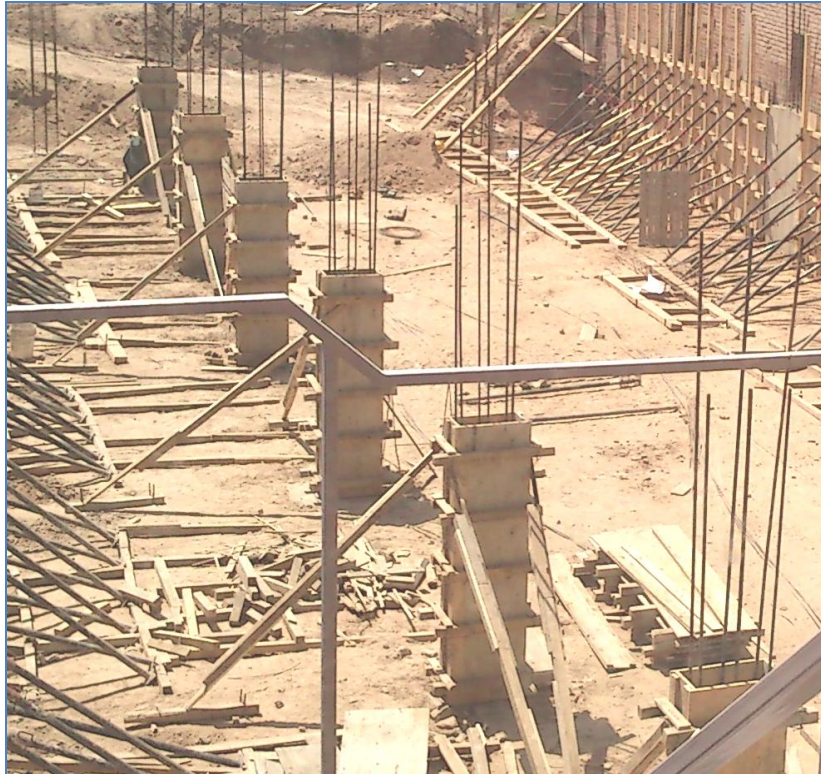
Figura 4.3.4: Detalle de las características de los empalmes a realizar según cálculo.
