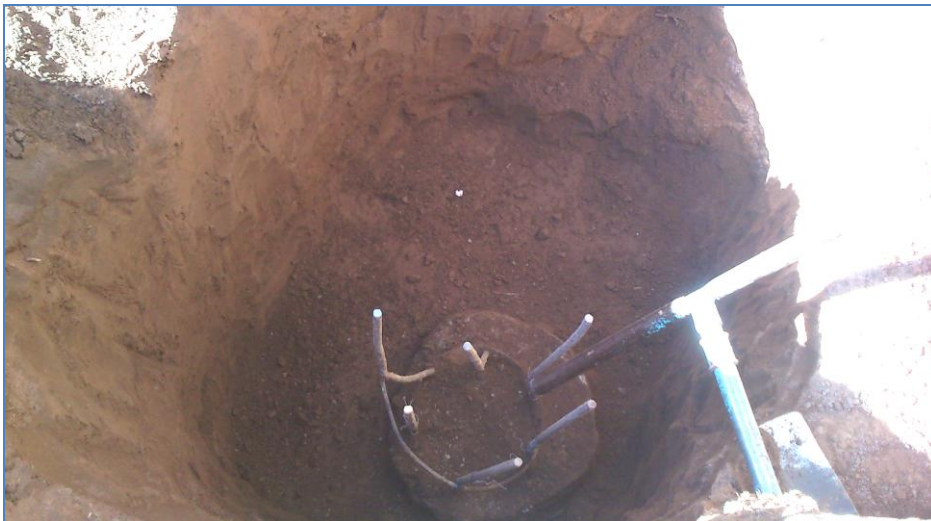
Figura 4.2.8: Excavación para la construcción del cabezal.
