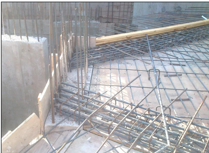
Figura 4.4.8: Vista del armado de las vigas de apoyo y losa de rampa de circulación.
