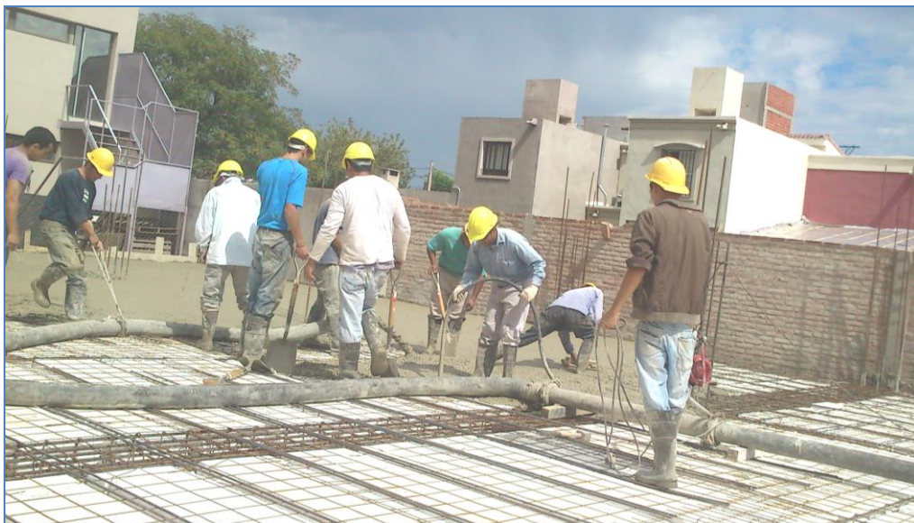
Figura 4.3.23: Imagen tomada durante el hormigonado de la losa nervurada.
