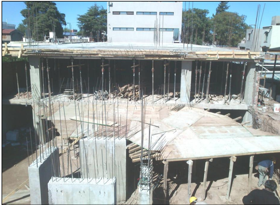
Figura 4.4.5: Vista del encofrado de la rampa de circulación.
