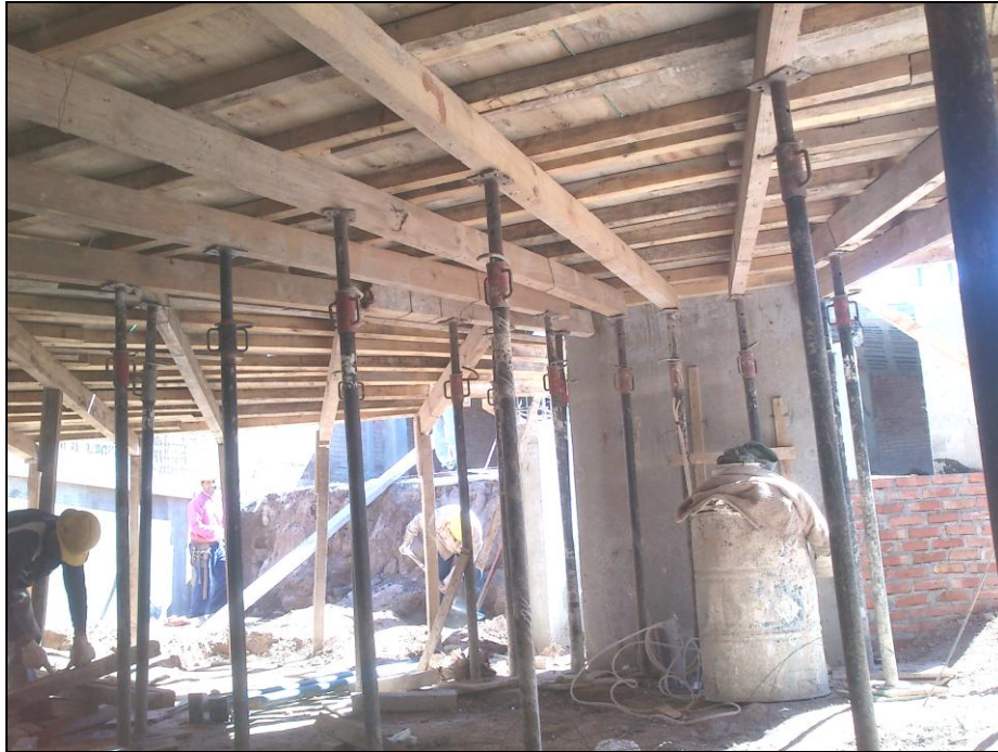
Figura 4.4.3: Imagen inferior del encofrado de la rampa de circulación.
