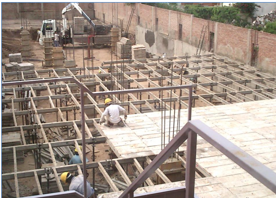
Figura 4.3.8: Fotografía tomada durante el montaje del sistema de encofrados en la obra.
