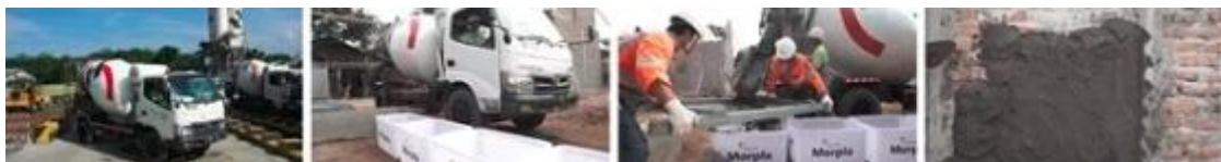
Figura N° 17. Proceso de entrega y descarga en obra del MLV
