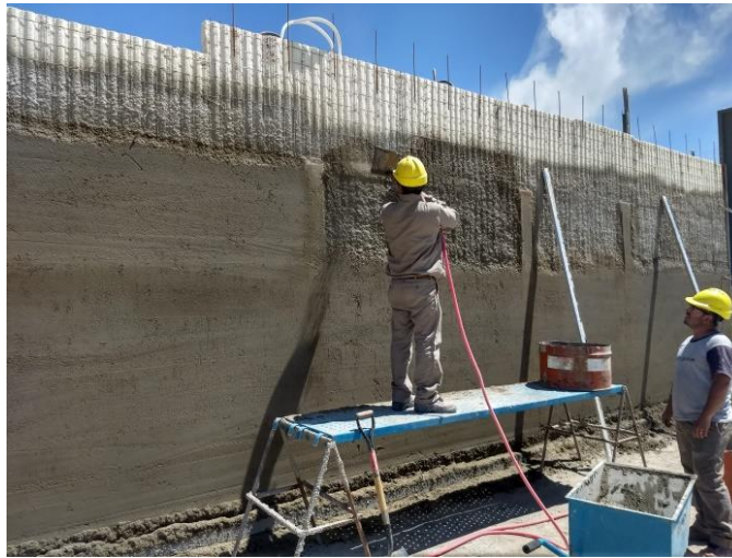
Figura N° 15. Revoque del sistema constructivo (se observa al oficial y medio oficial).
