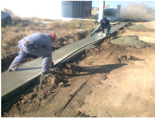
IMAGEN 4.6.8 – Terminación Superficial Del Hormigón
