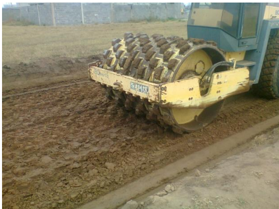
IMAGEN 4.3.4 – Compactación de la Subrasante
