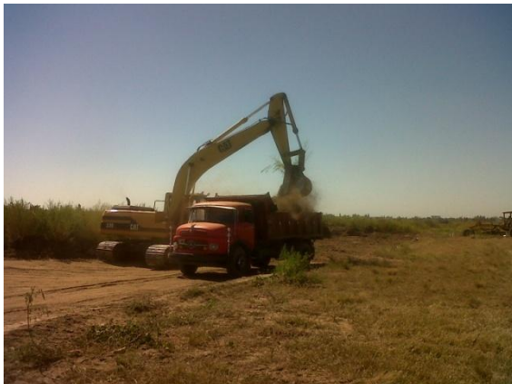
IMAGEN 4.2.3 – Desmonte con Retroexcavadora
