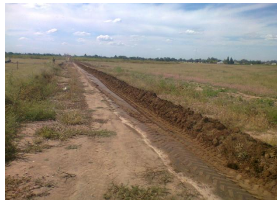
IMAGEN 4.1.2 - Limpieza de Terreno
