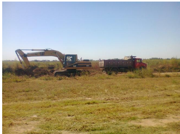
IMAGEN 4.2.2 – Desmonte con Retroexcavadora
