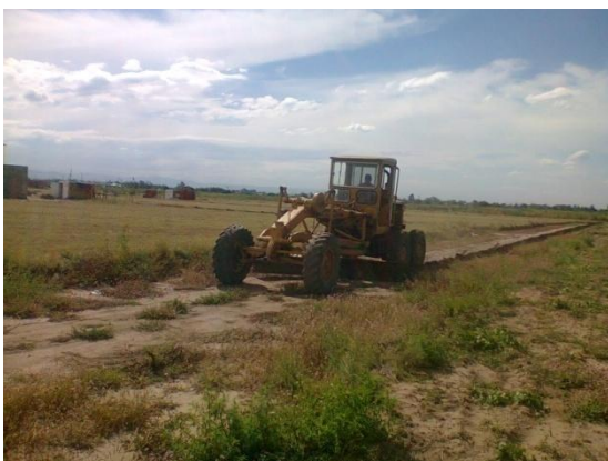
IMAGEN 4.1.1 – Limpieza de Terreno
