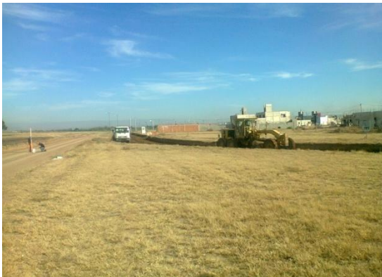
IMAGEN 4.3.1 – Humedecimiento del Material de Subrasante
