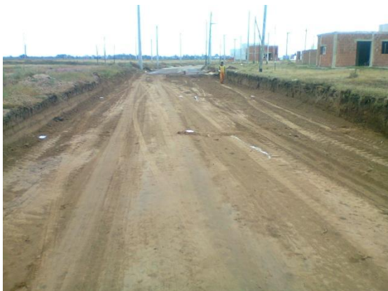
IMAGEN 4.2.4 – Aproximación de Niveles en Subrasante
