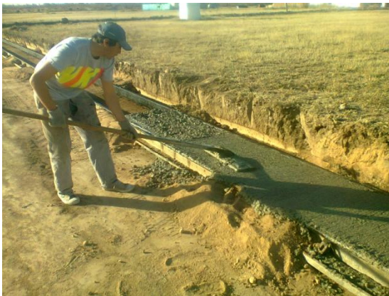
IMAGEN 4.6.6 – Terminación Superficial del Hormigón
