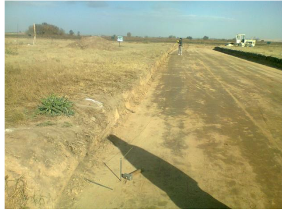
IMAGEN 4.6.2 – Nivelación de Cordón Cuneta
