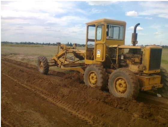
IMAGEN 4.1.3 - Limpieza de Terreno
