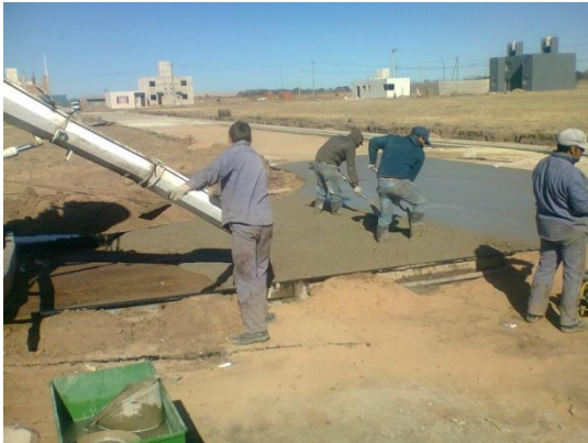
IMAGEN 4.6.4 – Colado del Hormigón
