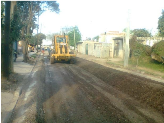
IMAGEN 4.7.1 – Preparación Base Granular
