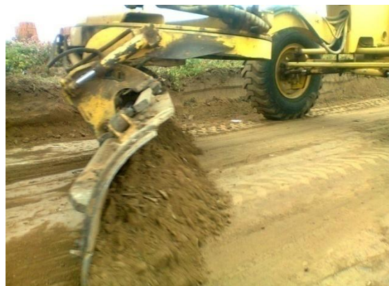
IMAGEN 4.2.5 – Aproximación de Niveles en Subrasante
