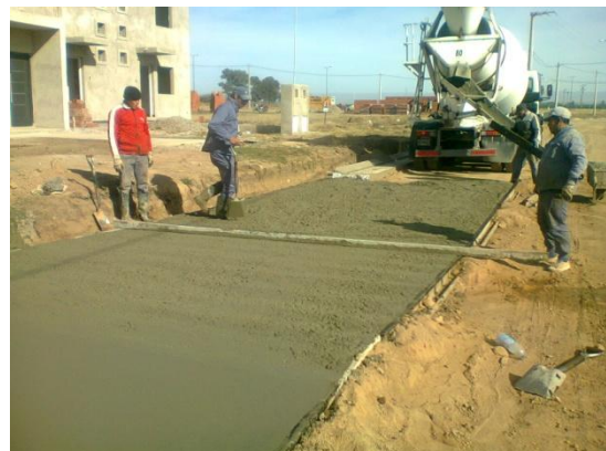
IMAGEN 4.6.7 – Terminación Superficial Del Hormigón
