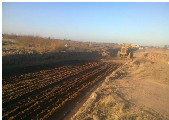
IMAGEN 4.3.3 Humedecimiento del Material de Subrasante
