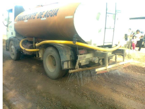
IMAGEN 4.7.2 Preparación Base Granular
