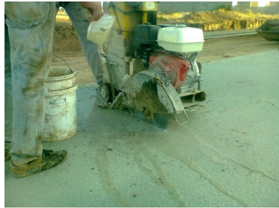
IMAGEN 4.6.9 – Confección de Juntas de Dilatación
