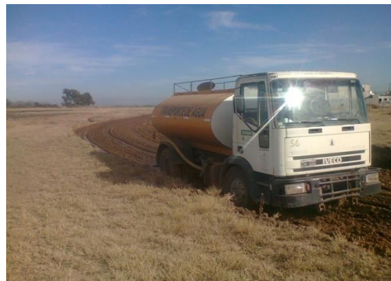
IMAGEN 4.3.2 - Humedecimiento del Material de Subrasante
