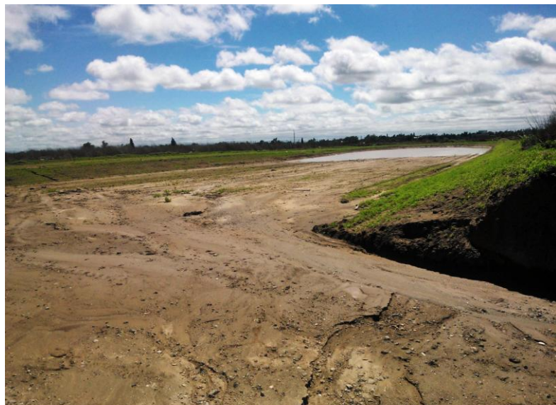
IMAGEN 8.2.1 – Obra Terminada / Laguna de Retención
