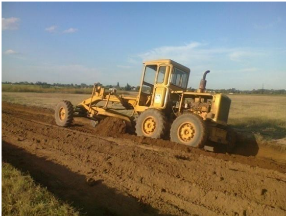
IMAGEN 4.2.1 – Desmonte con Motoniveladora
