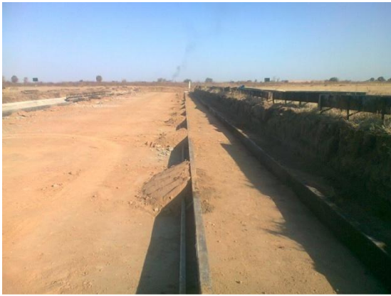
IMAGEN 4.6.1 – Fijación de los Encofrados
