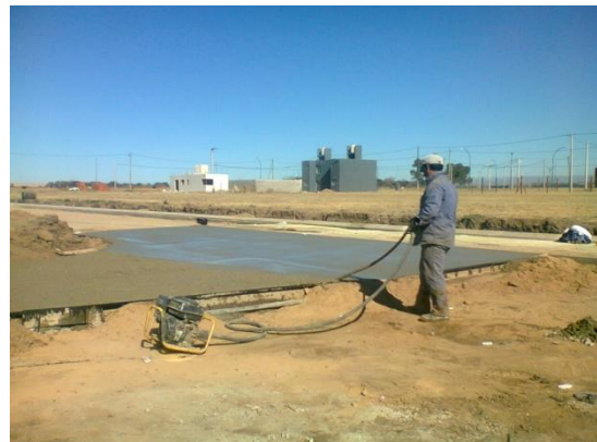
IMAGEN 4.6.5 – Vibrado del Hormigón
