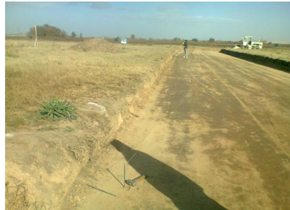
IMAGEN 4.5.5 – Superficie de Subbase terminada
