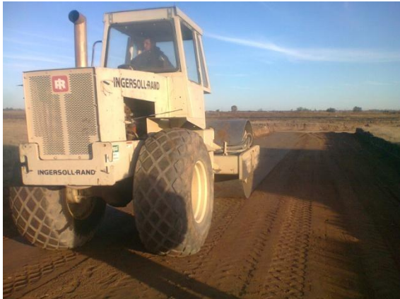
IMAGEN 4.5.4 – Compactación de Subbase
