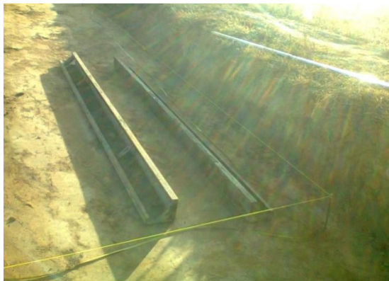
IMAGEN 4.6.3 – Nivelación de Cordón Cuneta
