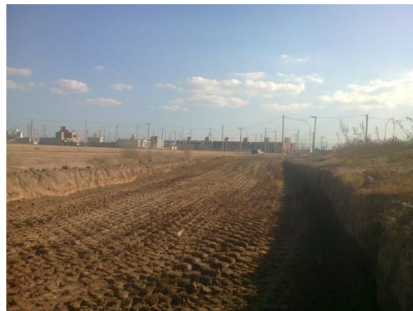
IMAGEN 4.3.5 - Compactación de la Subrasante
