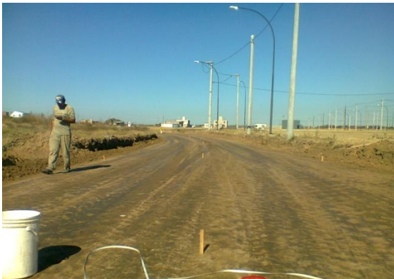
IMAGEN 4.3.6 – Nivelación de Subrasante
