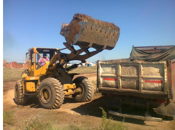
IMAGEN 4.1.4 - Limpieza de Terreno
