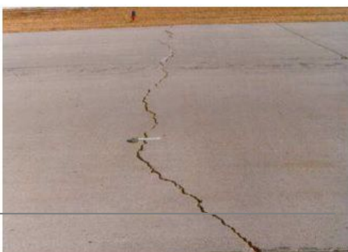
Fisura Transversal
