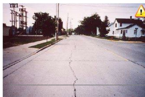
Fisura Longitudinal
