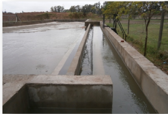
Figura 12: Cámara de ingreso del Río Grande.
