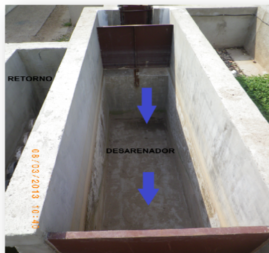
Figura 16: Desarenador.
