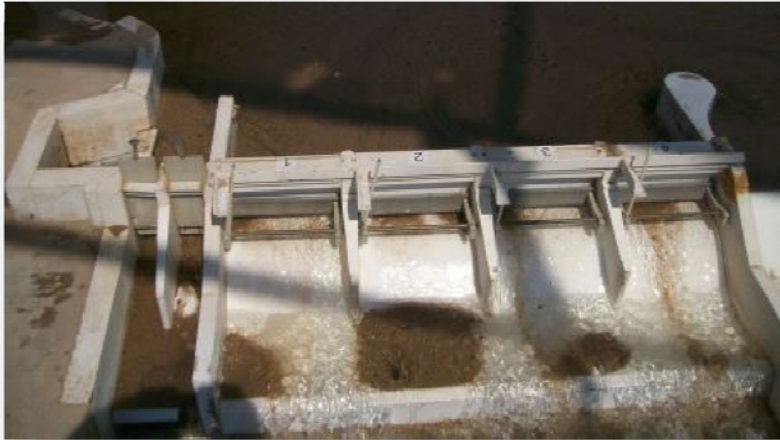
Figura 21: Cuarta etapa de la metodología I de aperturas de compuertas.
