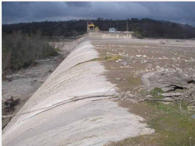
Figura 4: Tarquinamiento del dique.
