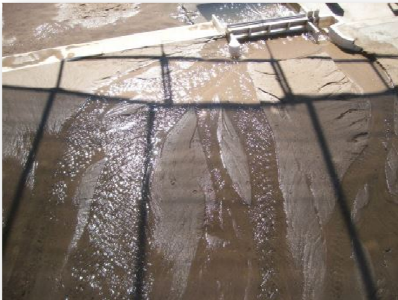
Figura 22: cuarta etapa de la metodología I de aperturas de compuertas.
