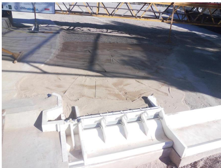
Figura 44: Nivelación del terreno
