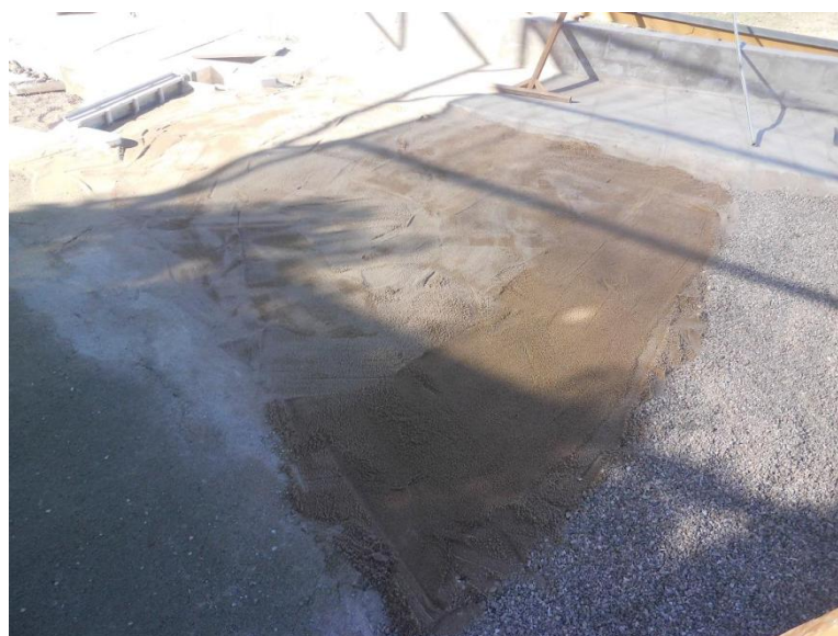
Figura 45: Nivelación del terreno
