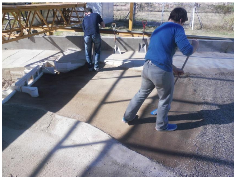
Figura 43: Nivelación del terreno
