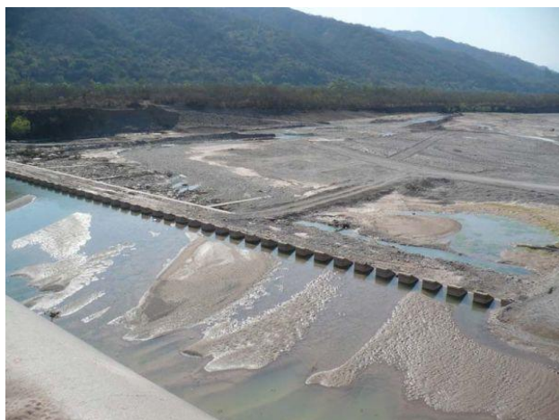
Figura 5: Erosión generalizada en el lecho del río
