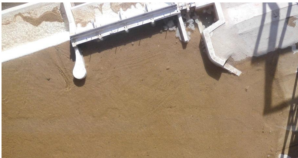
Figura 46: Condición inicial aguas arriba
