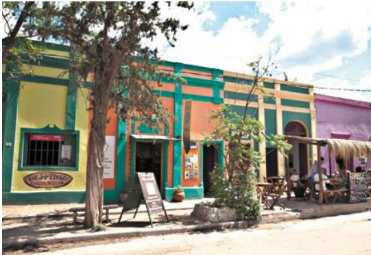
Figura N°2: Vista de la calle principal con recuperación de fachadas.
