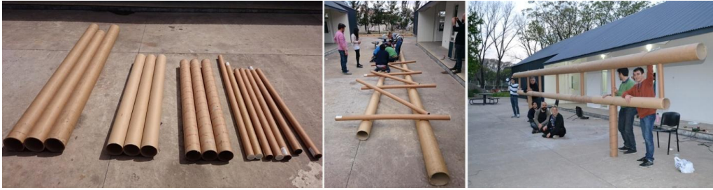
Figura 8. Construcción de viga reticulada a partir de residuos industriales, trabajo realizado en el TAU 2015.
