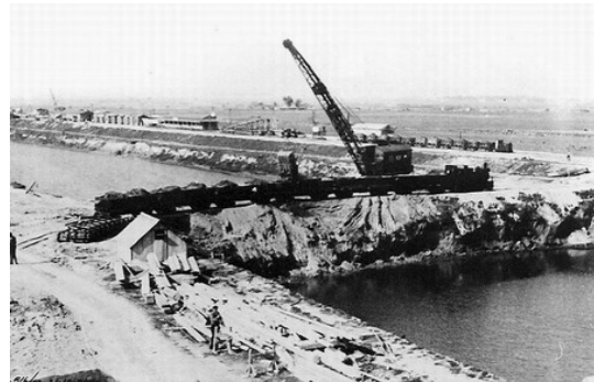
Figura 70 Excavación del Riachuelo en 1927
