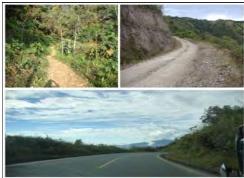
FIG V.55 Vías: Sendero, Lastrada y Pavimentada
