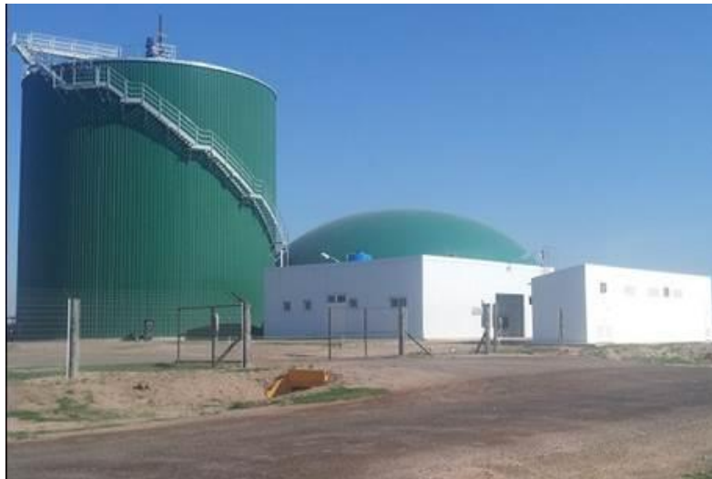
Figura 34. Planta de Biogás "Rio Cuarto I", Prov. de Córdoba. ( www.bioelectrica.com )
