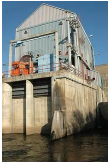
Figura 42. Central Hidroeléctrica “Piedras Moras”, Almafuerte, Córdoba. ( www.epec.com.ar )
