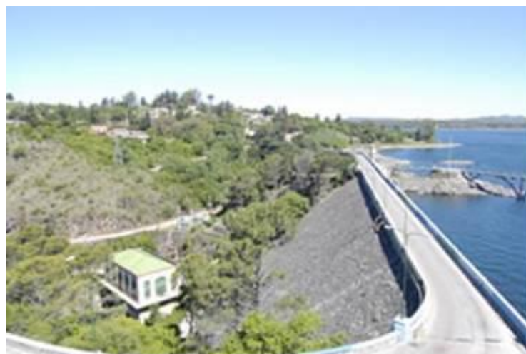
Figura 41. Central Hidroeléctrica "Fitz Simon", Embalse, Córdoba. ( www.epec.com.ar )
