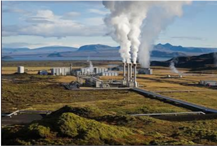
Figura 12. Planta Geotérmica de Nesjavellir, Islandia. (www.wikipedia.org)
