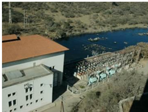
Figura 43. Central Hidroeléctrica “Cassafousth”, Embalse, Córdoba. ( www.epec.com.ar )
