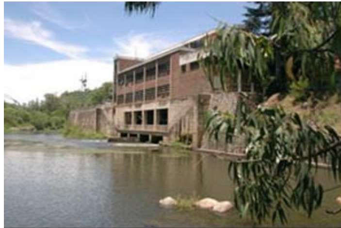
Figura 40. Central Hidroeléctrica "San Roque", La Calera, Córdoba. ( www.epec.com.ar )
