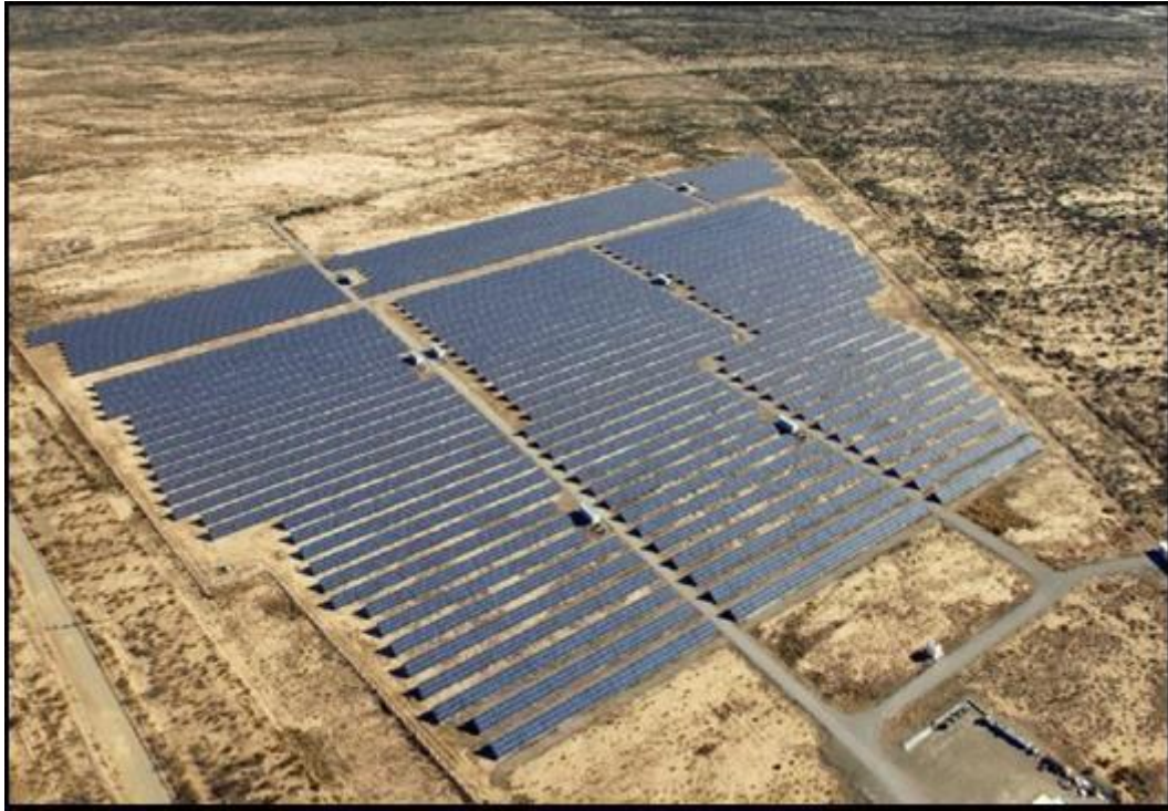
Figura 31. Planta Solar Fotovoltaica Cañada Honda I y II, San Juan. ( www.tiempodesanjuan.com/plantas-fotovoltaicas )
