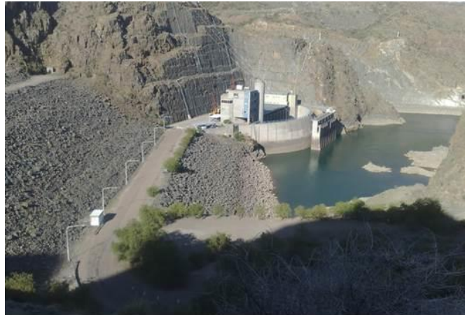
Figura 38. Central Hidroeléctrica "Los Reyunos", San Rafael, Mendoza. Potencia instalada: 224 MW. ( www.es.wikipedia.org/ )
