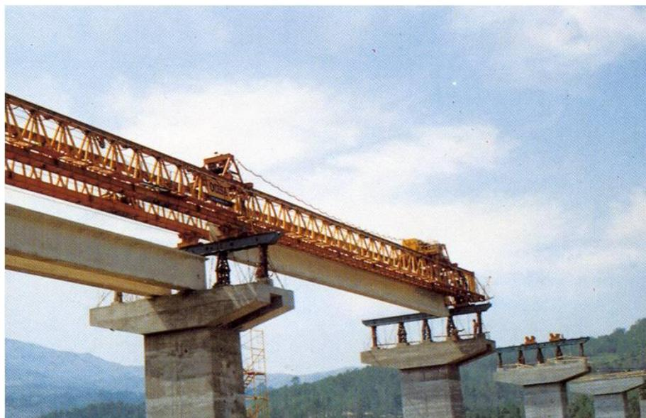
Figura 4: Cimbra autoportante lanzadora de vigas.
