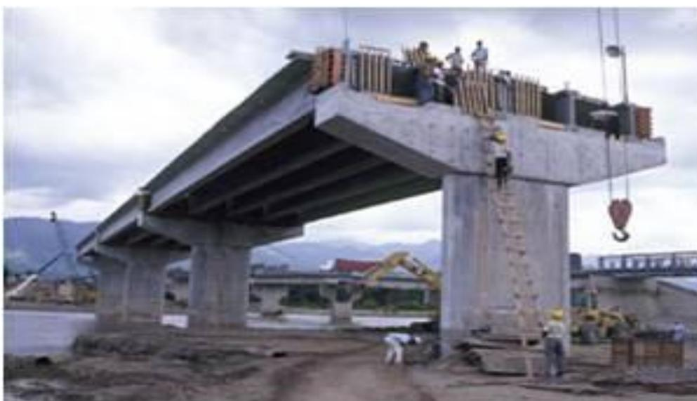
Figura 6: Puente de vigas prefabricadas.
