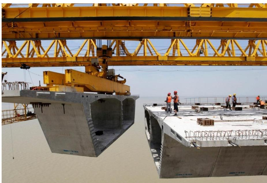
Figura 5: Cimbra autoportante lanzadora de vigas.
