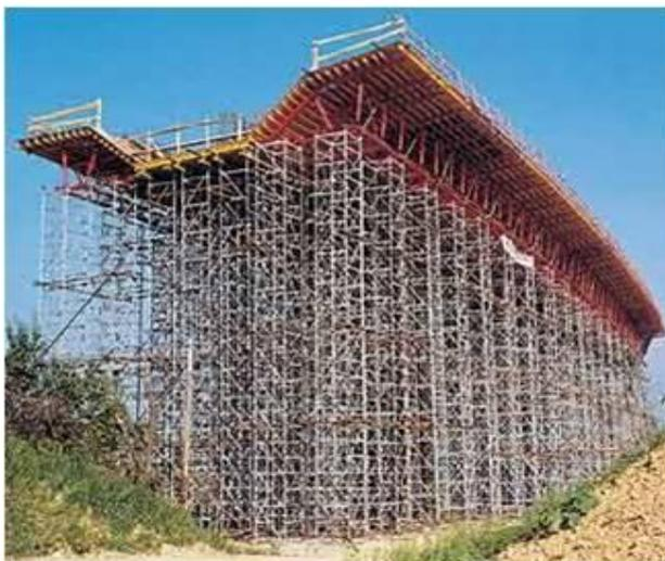
**Figura 3: Cimbra de losa de puente pretensado apoyada sobre el terreno.**
