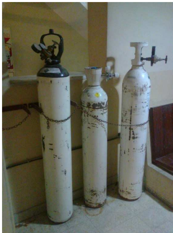
Imagen 3.8.- tubos de oxígeno cerca de UTI
