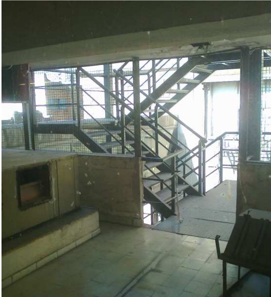
Imagen 2.3.- escalera externa EE1 desde el primer piso
