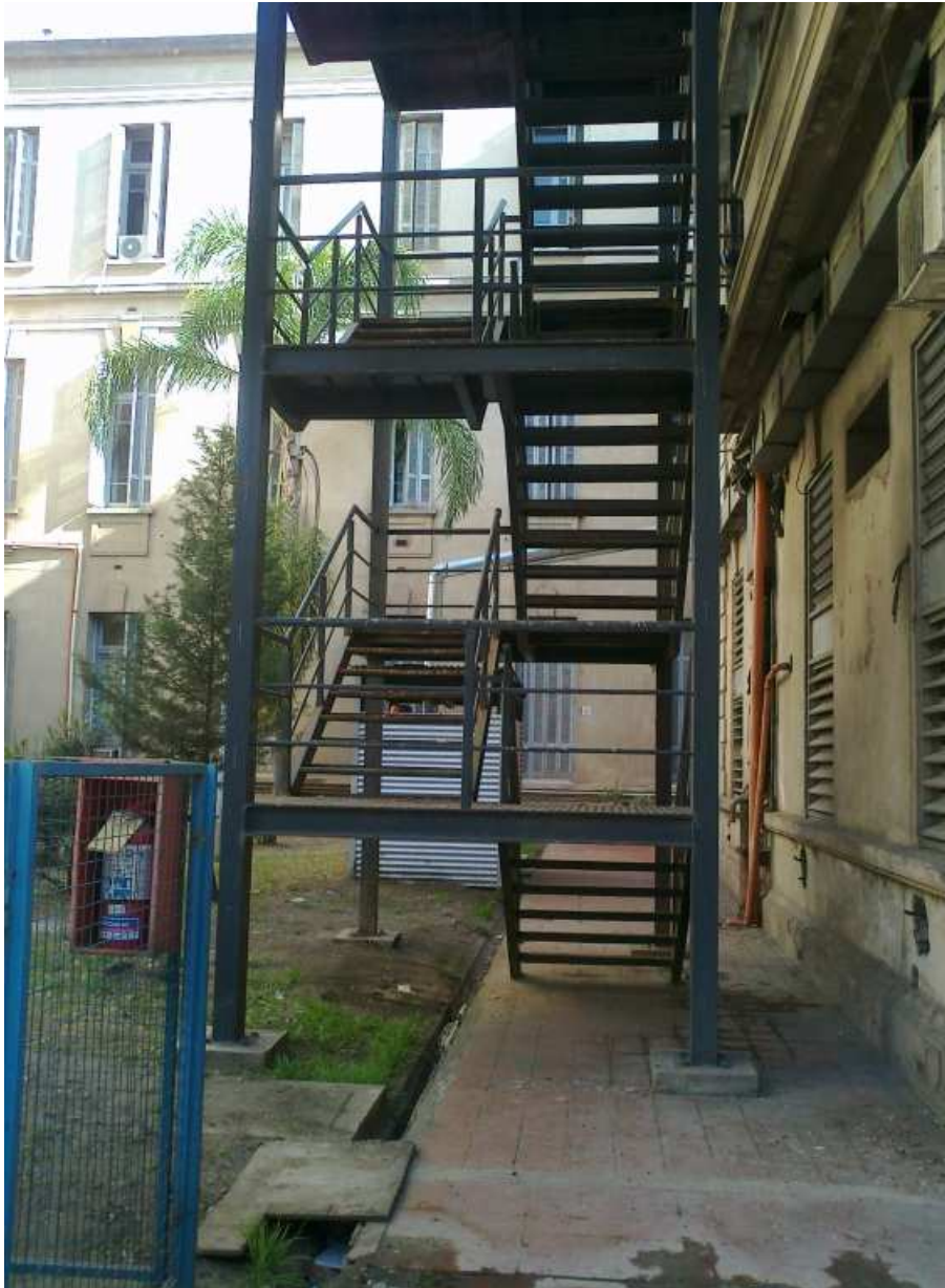
Imagen 2.2.- escalera de emergencia EE1
