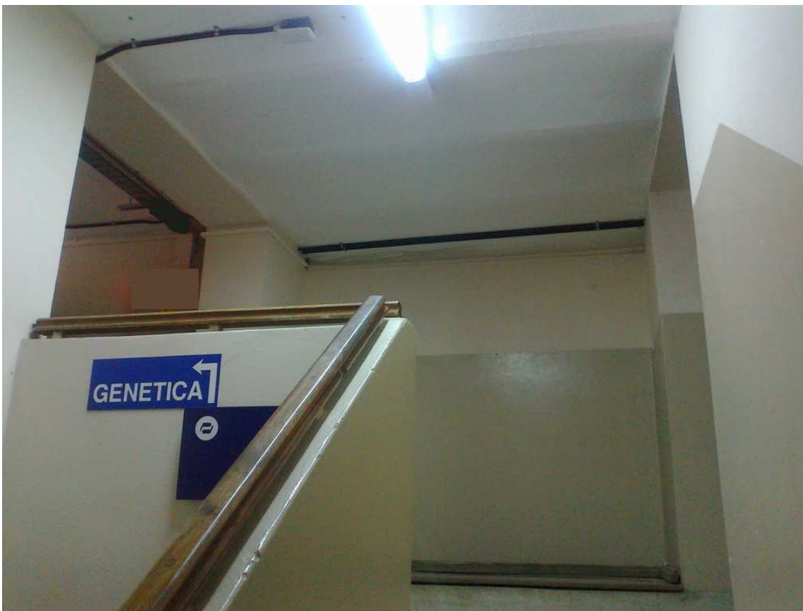
Imagen 2.10.- sectorización en el segundo entrepiso, puntos 1 y 2
