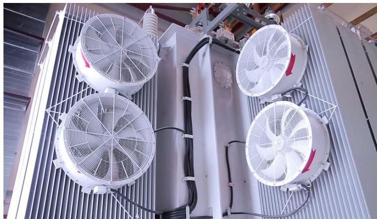
Fig. 9 SISTEMA DE REFRIGERACIÓN DE UN TRANSFORMADOR
