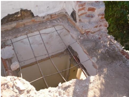
Figura 3.2.6. Demolición de losa.
