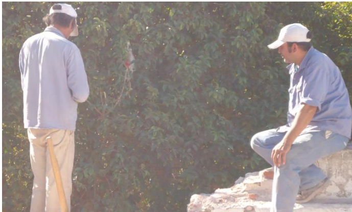
Figura 3.2.10. Falta de utilización de casco.
