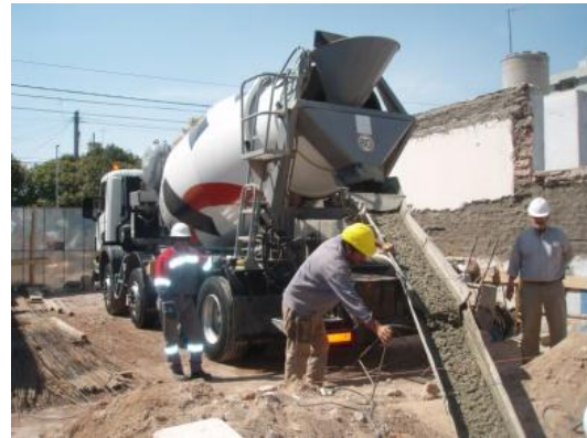
Figura 3.10.7. Hormigonado de pozos de fundación.
