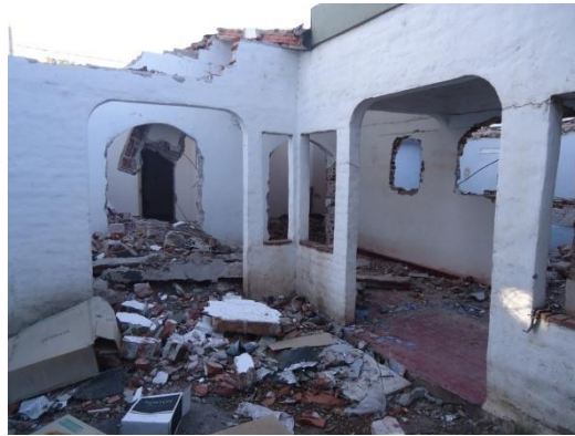
Figura 3.2.2 Proceso de desmantelado.
