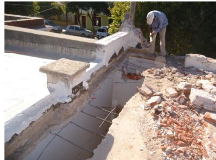
Figura 3.2.7. Desvinculación de losas.
