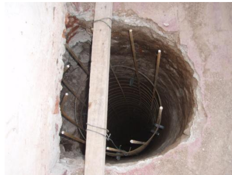
Figura 3.10.5. Utilización de separadores plásticos.
