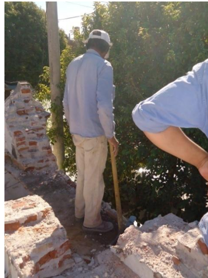
Figura 3.2.9. Personal de demolición
