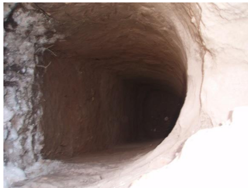
Figura 3.10.3. Forma de excavación de pozos.
