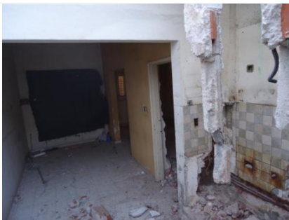
Figura 3.2.3. Desmantelado de cocina.
