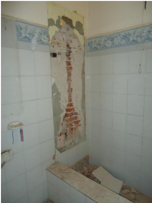
Figura 3.2.1. Proceso de desmantelado
