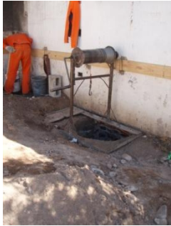
Figura 3.10.4. Excavación manual de pozos.
