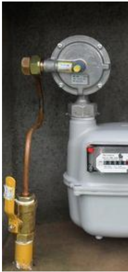
Figura 3.6.9. Regulador de presión de gas.
