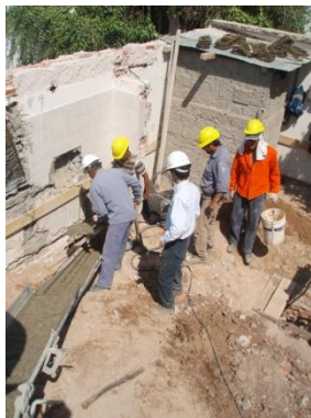
Figura 3.10.8. Hormigonado de fundación.
