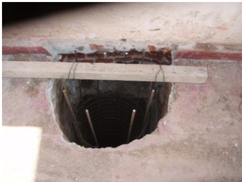
Figura 3.10.4. Colgado de armadura.
