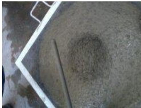
Fig. N° 5.7 Extendido segregado
