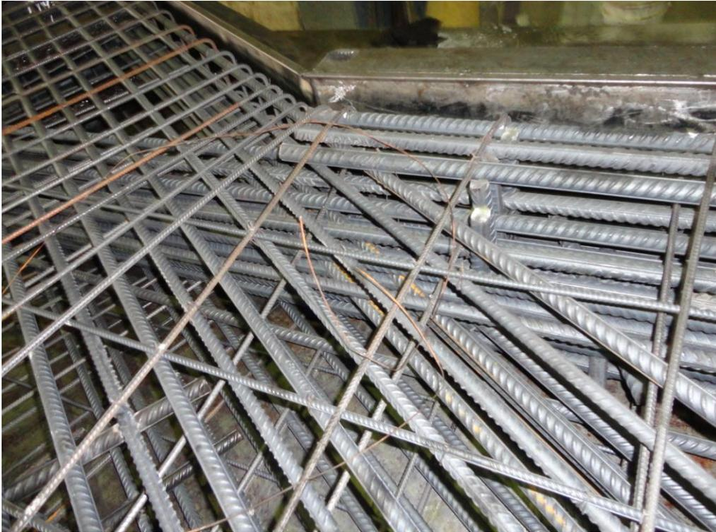
Fig N° 5.16 Espaciamiento de armaduras
