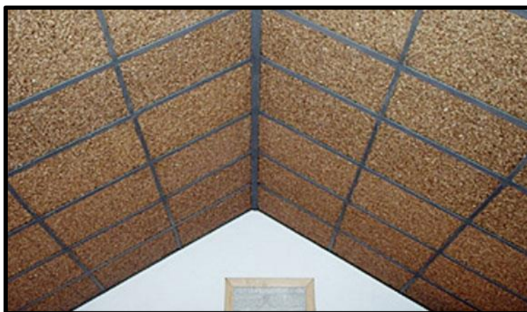
Figura 3: Placas de aglomerado de cáscara de maní.
