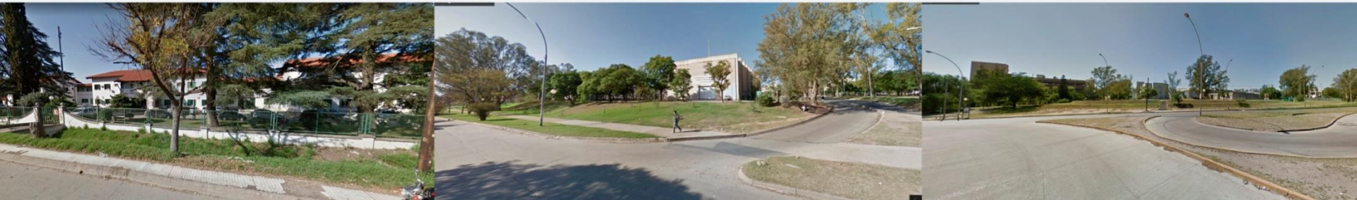
BORDE OESTE - FALTA COMPLETAMIENTO DEL BORDE
