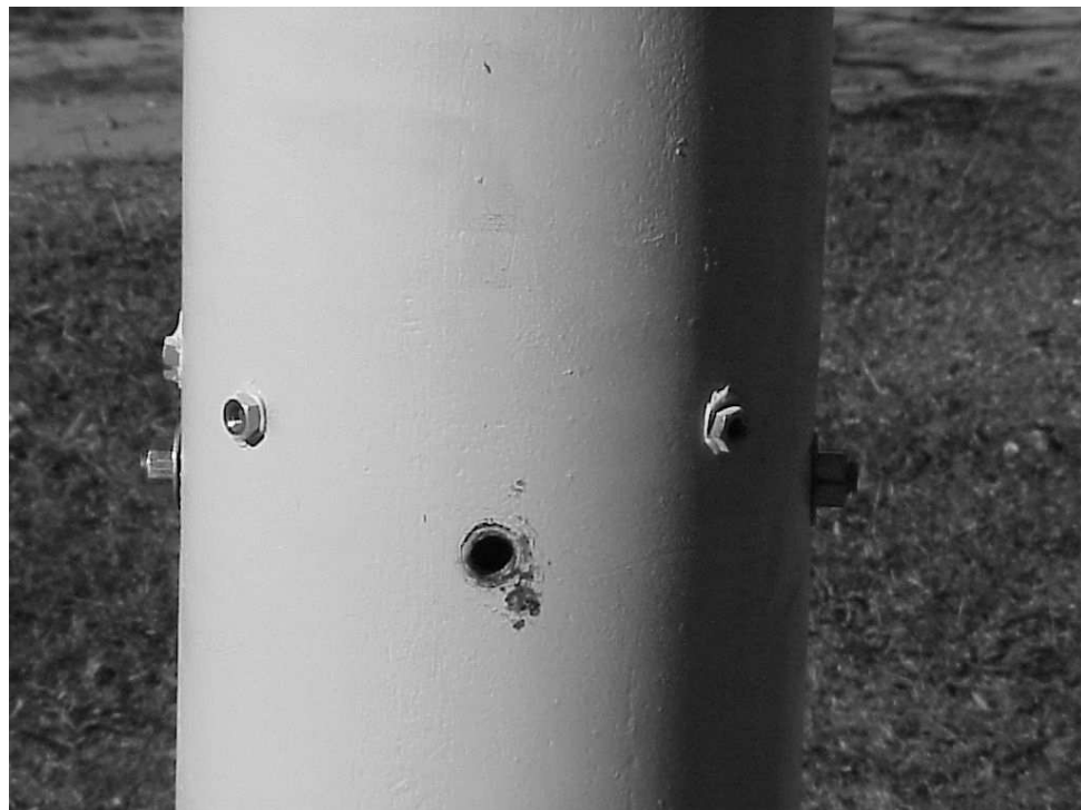
Fig. 9.24: Perno de rigidización seccional de la estructura
