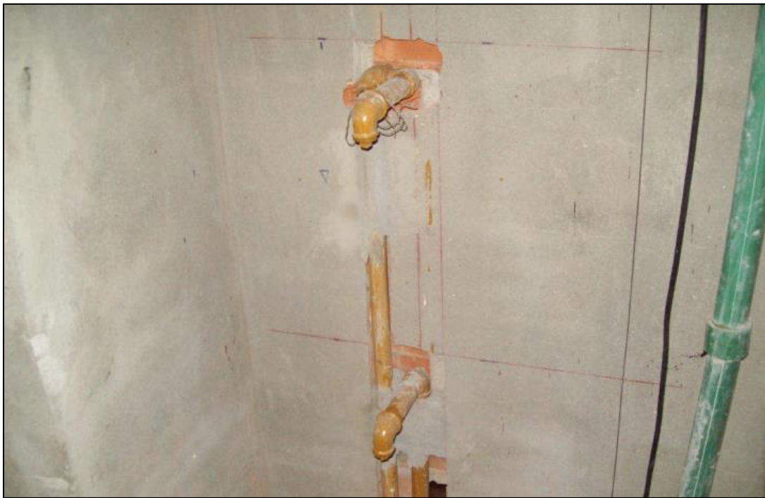
Instalación de Baterías de Medidores
