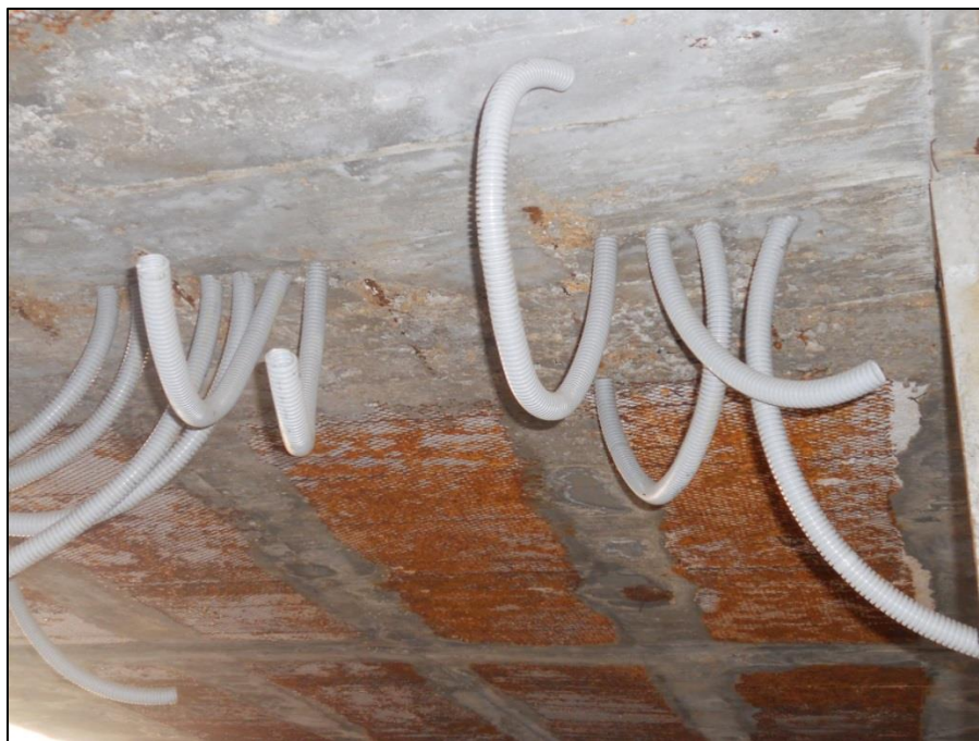
Canalizaciones en Losas de Planta Baja, con caño corrugado de 3/4"
