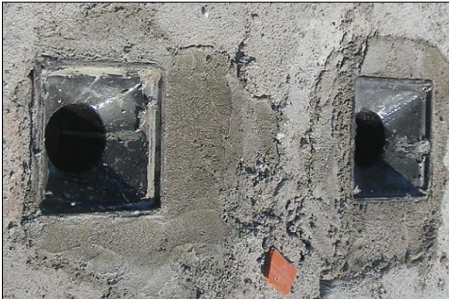
Embudos de Desagüe ya colocados
