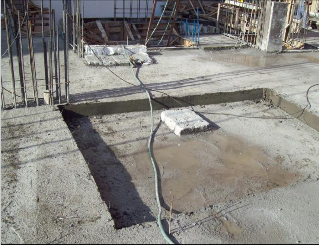
Bandeja Sanitaria Terminada
