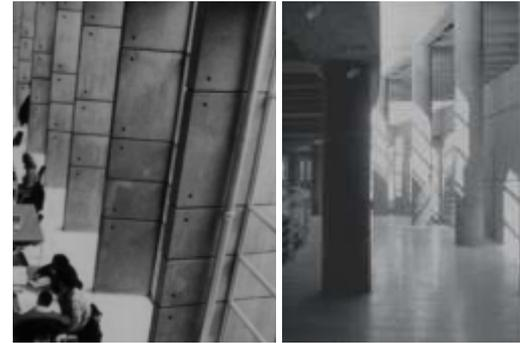
**Sistema estructural diferenciado.** Consiste en un sistema de vigas y columnas aporricadas con el que se resuelve la totalidad del edificio, adaptando tipos, geometría y dimensiones a cada sector del mismo.
