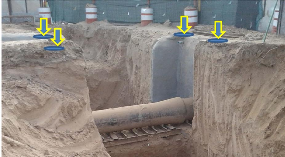
Figura 32: Puntos que se usarían de base para las vigas
