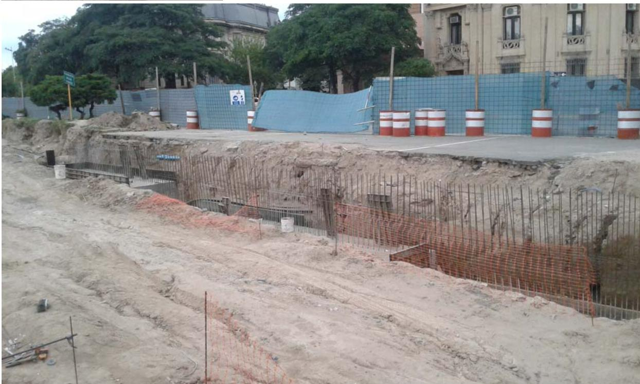
Figura 23: construcción de muros M1, M2 y M3
