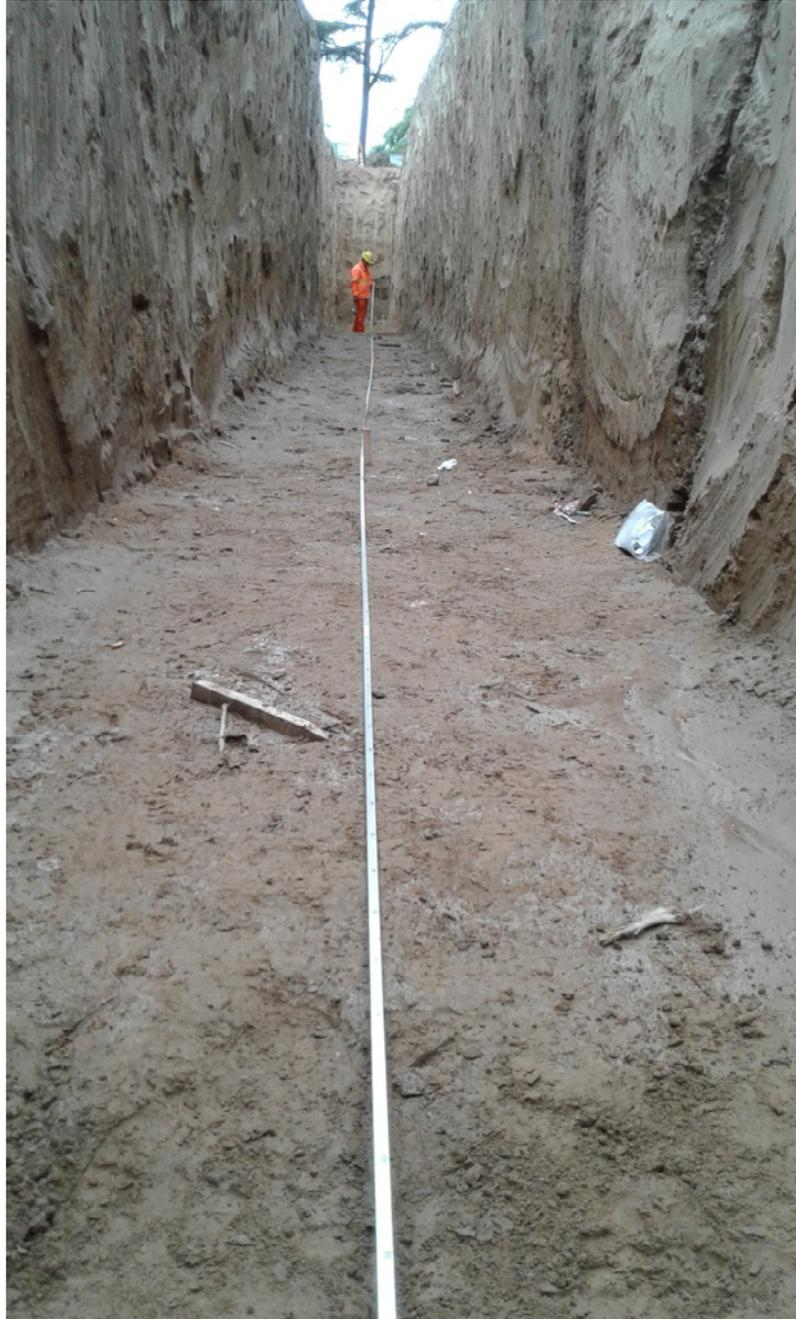
Figura 30: materialización de los puntos para determinar base de asiento.
