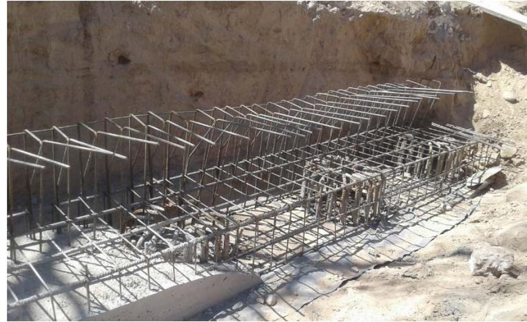
Figura 22: Colado y hormigonado de las vigas principales
