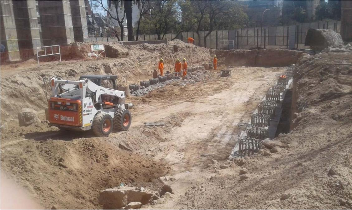
Figura 17: Desmoche, se rompe el hormigón hasta dejar expuestos los pelos
