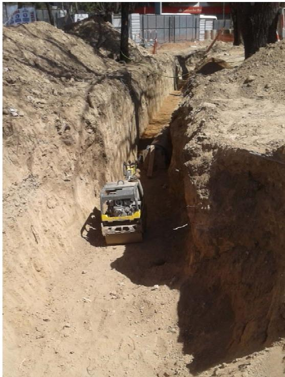
Figura 25: Compactación de la base granular.
