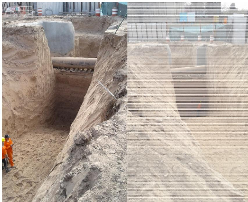
Figura 33: excavación para el sifón invertido
