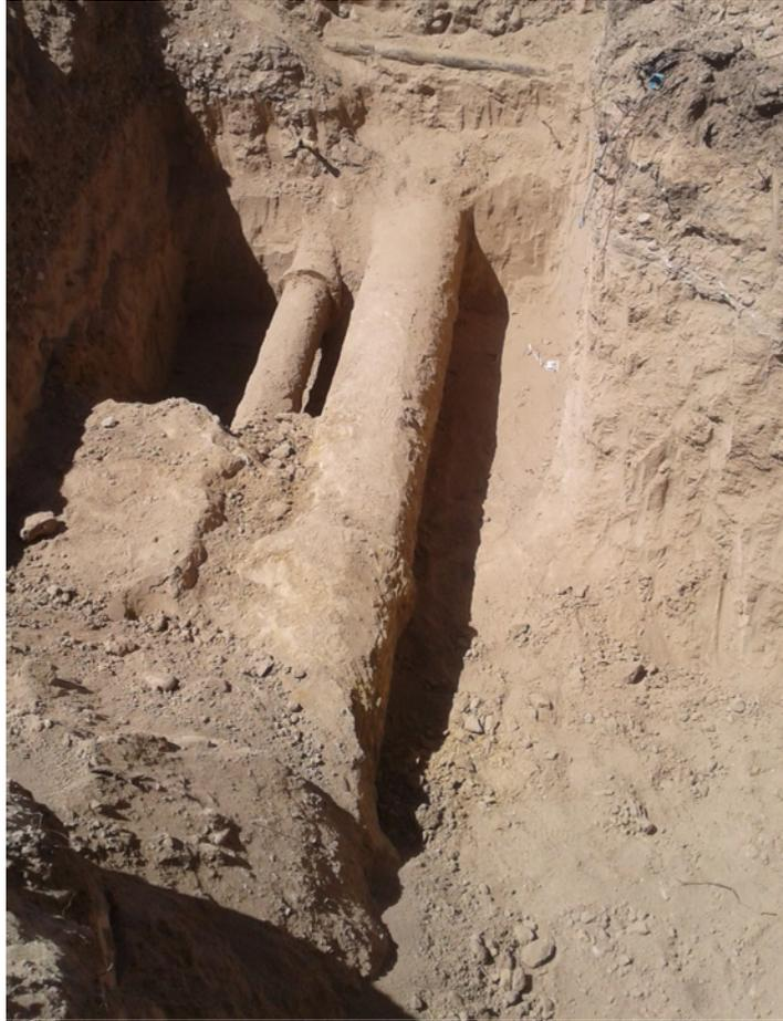
Figura 24: caño de agua de 500 mm de diámetro
