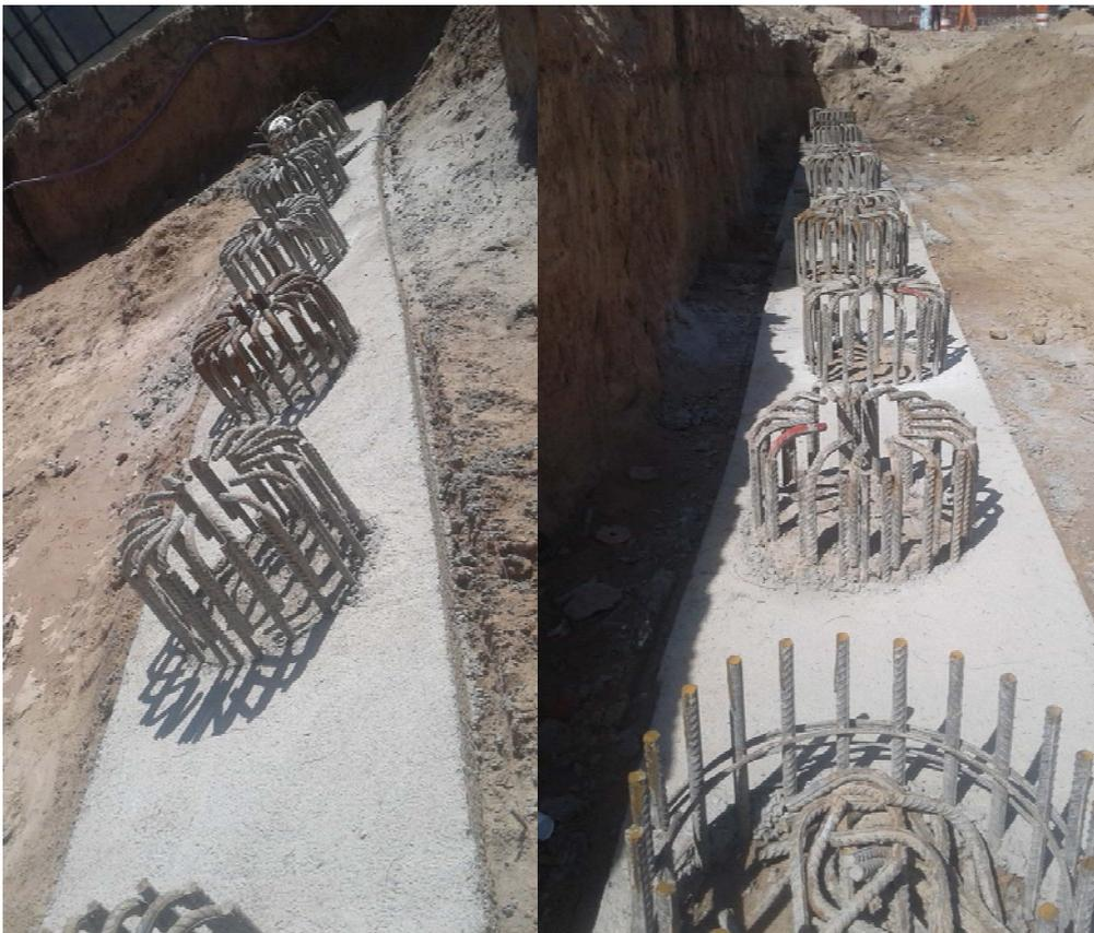
Figura 18: Pelos descubiertos con hormigón de limpieza
