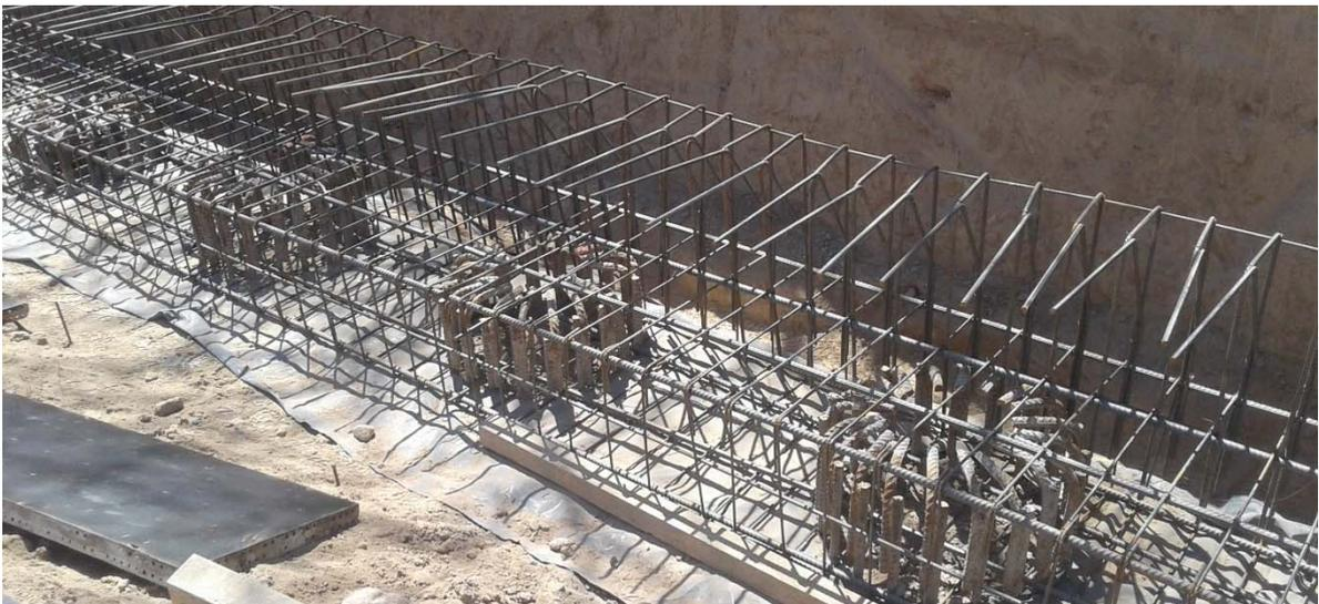
Figura 21: Armadura de viga principal
