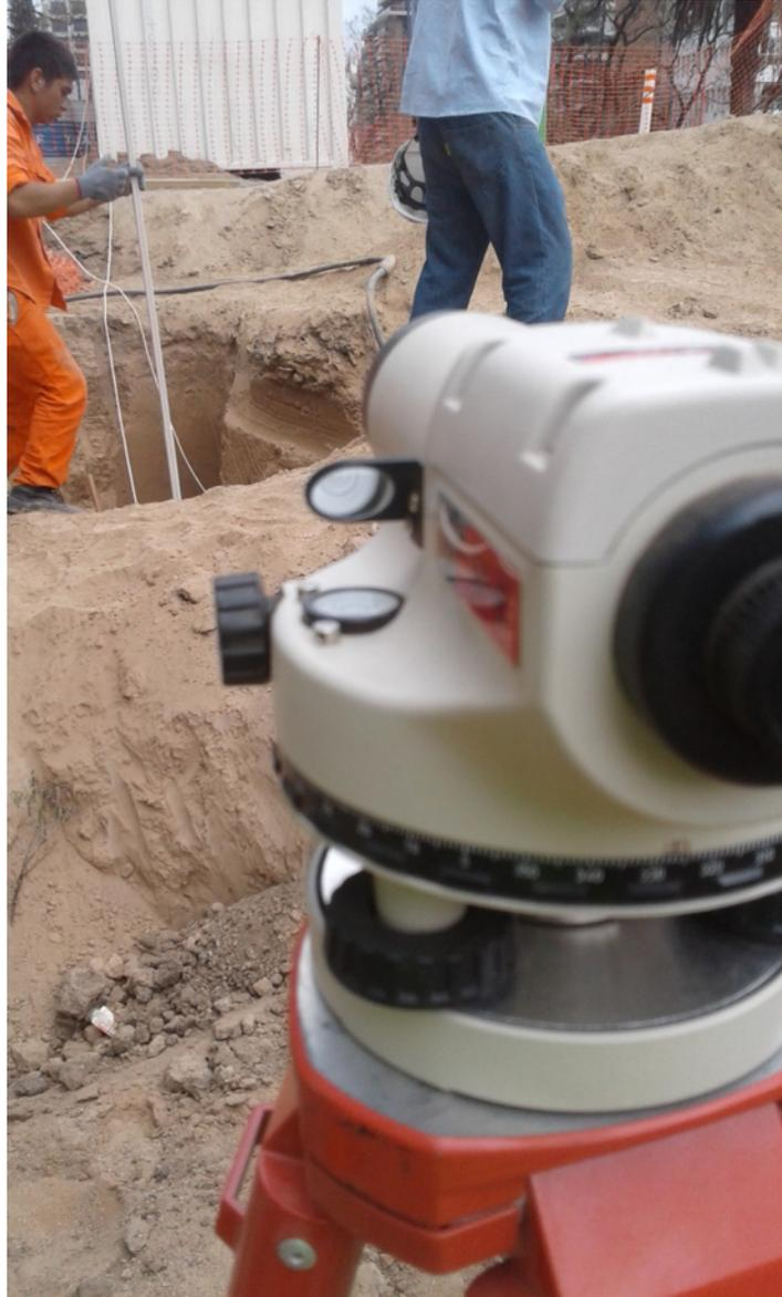
Figura 29: se toma lectura de cota de la base de zanja de ducto del caño de 700 mm
