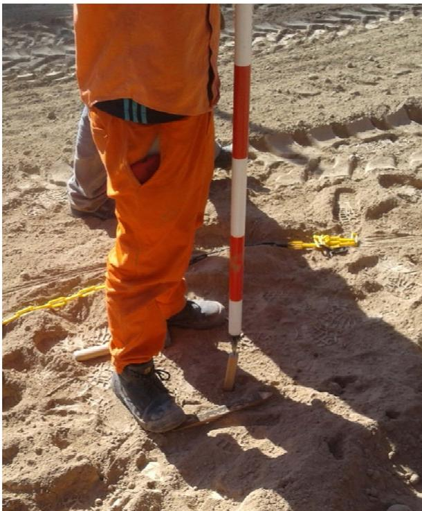
Figura13: Control de posición del punto y colocación de armadura de pilote
