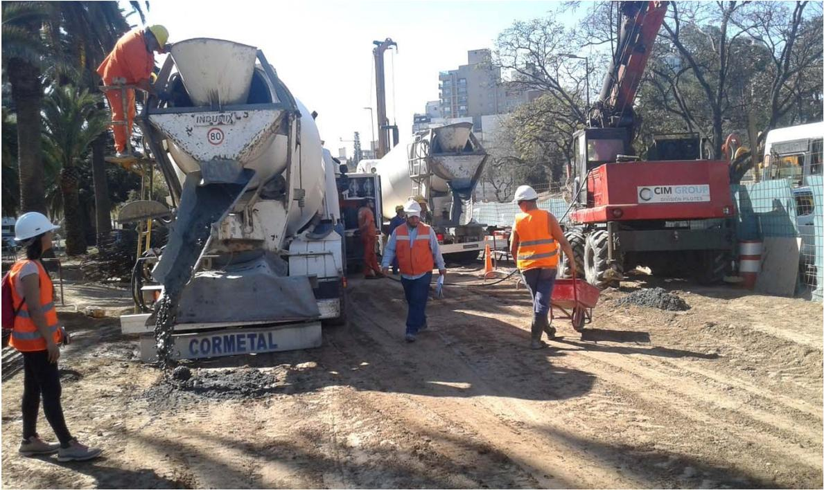
Figura 15: Colado del hormigón en las perforaciones.
