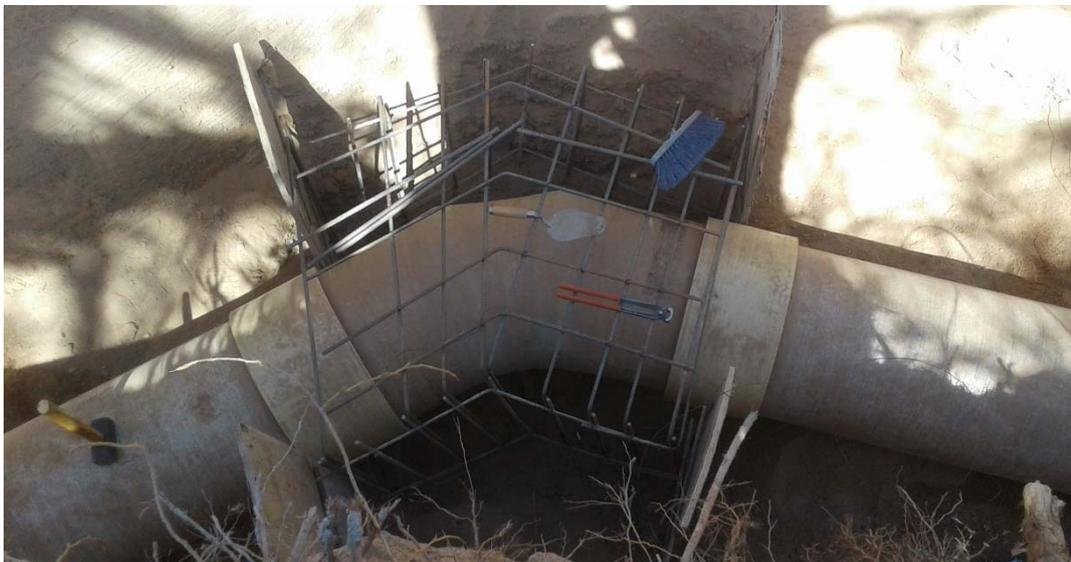
Figura 27: Quiebre de ducto, detalle de armadura y protección.
