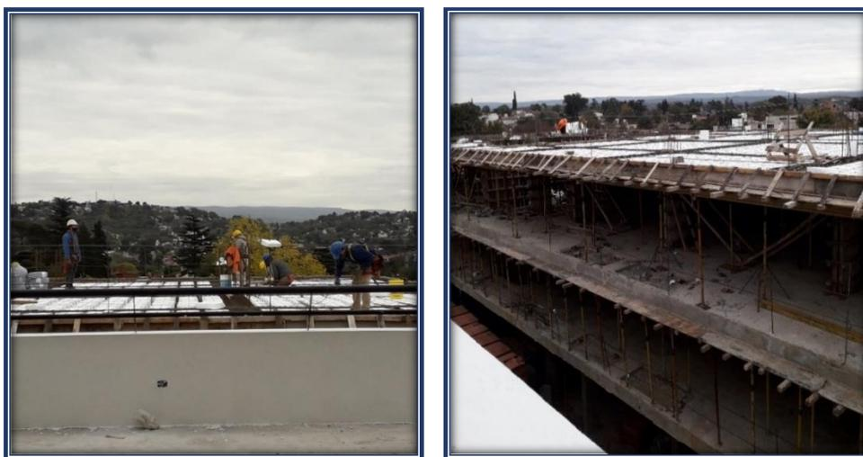
Fig. 7 – Riesgo: Caída a diferencia de nivel en colocación de armadura para losa
