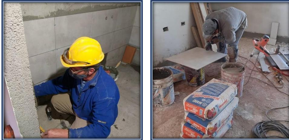
Fig. 9 – Relevamiento de postura forzada en colocación de pisos y revestimiento
