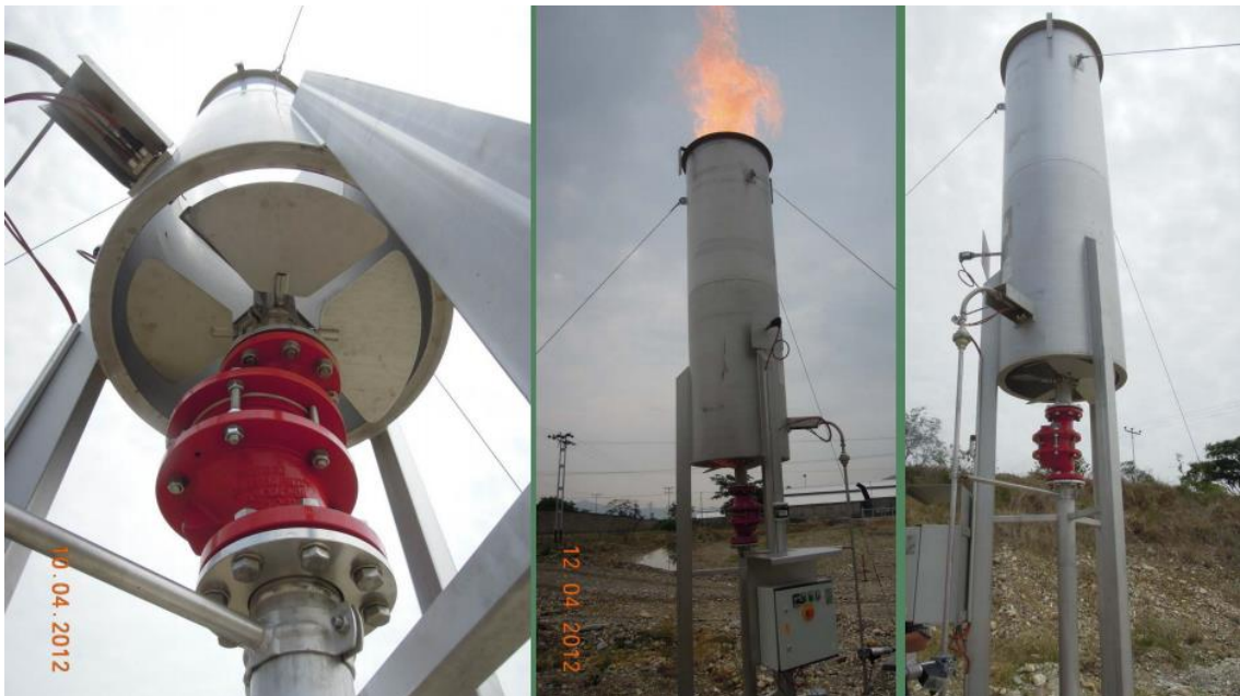
Figura 9: Antorcha tipo abierta de 350 m 3 /h de biogás cc
