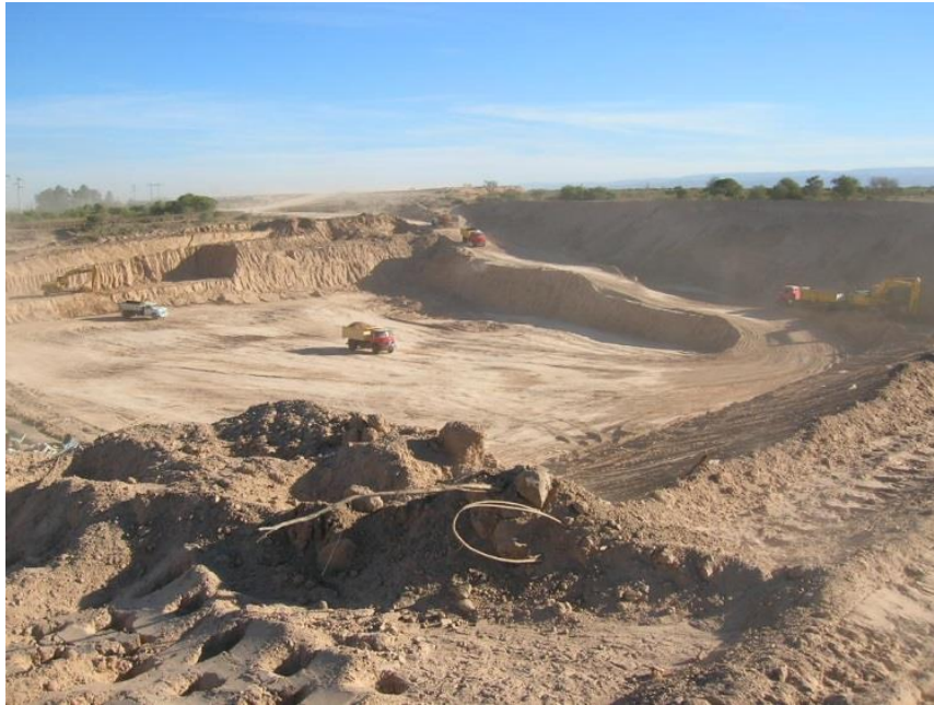
Figura 17: predio Piedras Blancas, movimiento de suelo.
