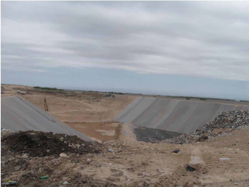
Figura 18: bermas en el vertedero, a la derecha de la misma se encuentra el lixiviado.
