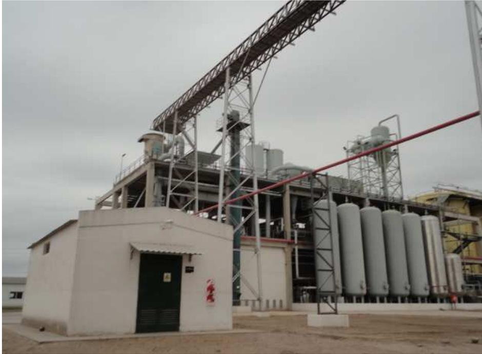
**Figura 11. Tanques de licuefacción, planta Bio4 Río Cuarto.**
