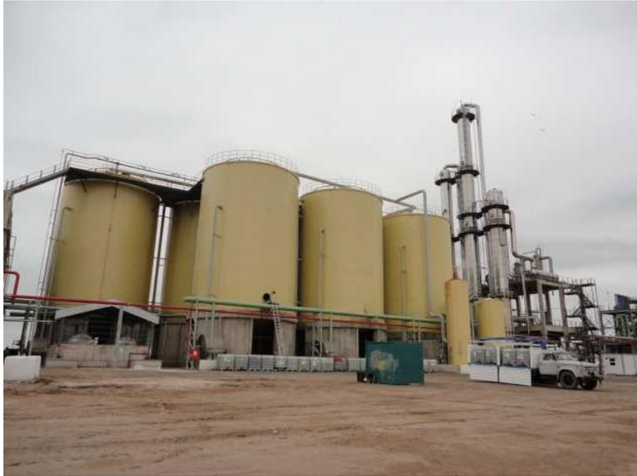
**Figura 12. Tanques de fermentación, planta Bio4 Río Cuarto.**
