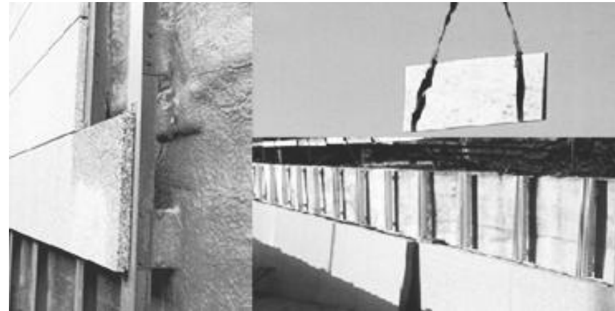
Fig. 48: Montaje de paneles sobre estructura metálica
