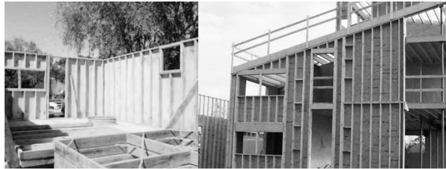
Fig. 25: Montaje de Sistema "Balloon Frame"
