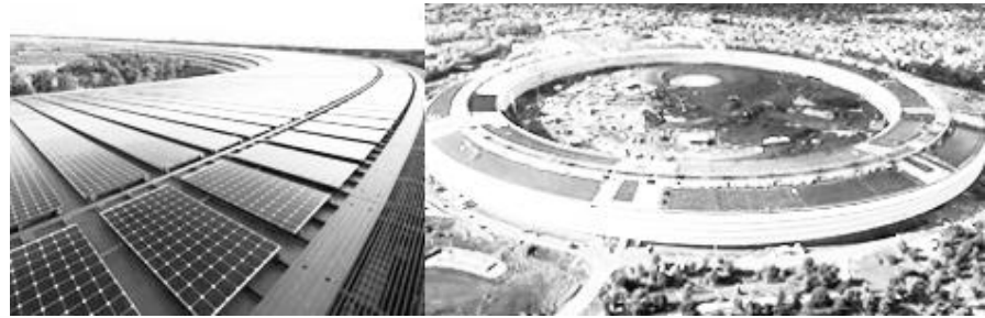
Fig. 75: Cubierta con paneles fotovoltaicos. Norman Foster. Apple Park. EEUU, 2017
