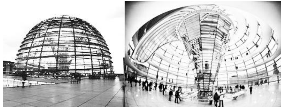
Fig. 76: Cubierta con parasoles móviles controlados por sistema de computación. Norman Foster. Cúpula del REICHSTAG. Berlín, 1992 - 1999
