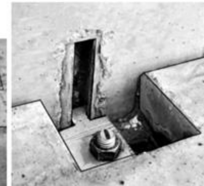
Guía Tipo Halfen para vincular piezas de Hormigón (La guía va inserta y no es portante, solo cumple la función de vincular)
