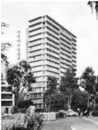
Fig. 71: El proyecto transforma la envolvente del edificio, construido en los años cincuenta, mejorando la respuesta climática y energética de los interiores y aportando una nueva imagen que influye positivamente en el entorno urbano próximo. Druot, Lacaton&Vassal. Torre Bois le Prêtre. Paris, 2011 14
