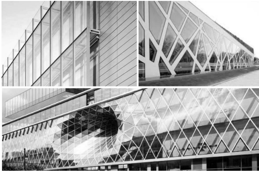
Fig. 32: Ejemplos de aplicación del vidrio estructural
