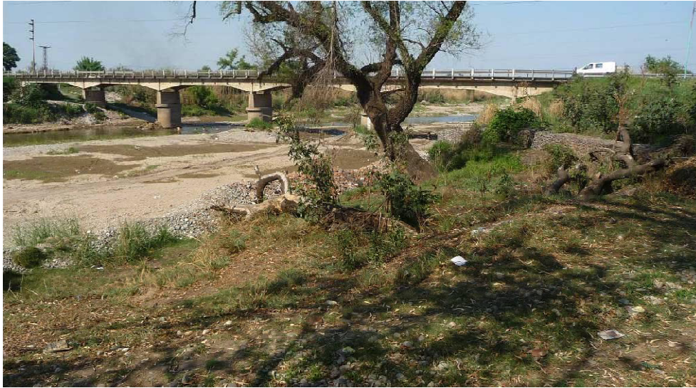
Figura 2.4. Vista desde agua arriba hacia agua abajo del puente carretero de la actual Ruta Nacional N°38, conformada por 6 vanos.
