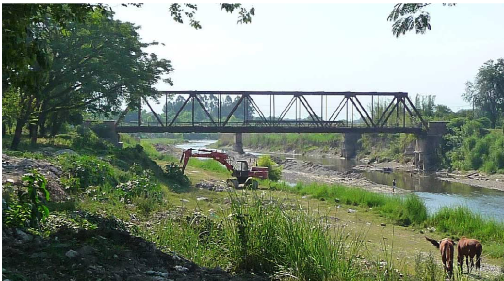
Figura 2.3. Vista hacia agua arriba del antiguo puente carretero, de un solo vano de 60m de luz libre. Hacia atrás se observan la pila central y el estribo norte del puente ferroviario.
