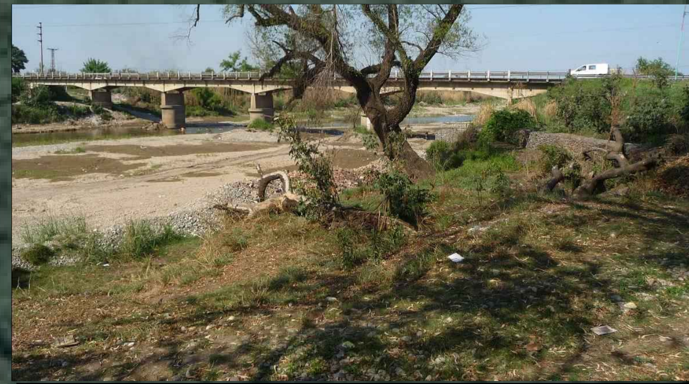
VISTA DESDE AGUAS ARRIBA HACIA AGUAS ABAJO DEL PUENTE CARRETERO ACTUAL DE LA RUTA NACIONAL N°38, CONFORMADO POR 6 VANOS.
